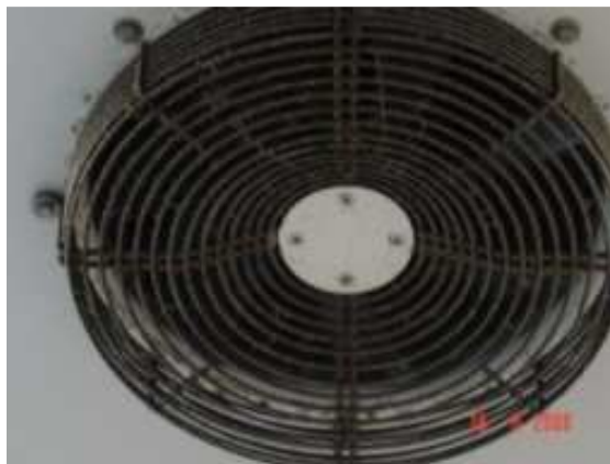
Obr. č. 5: B – silně znečištěné kryty větracích zařízení přímo nad posuvným pásem baličky, v místě kde prochází nebalený výrobek.
