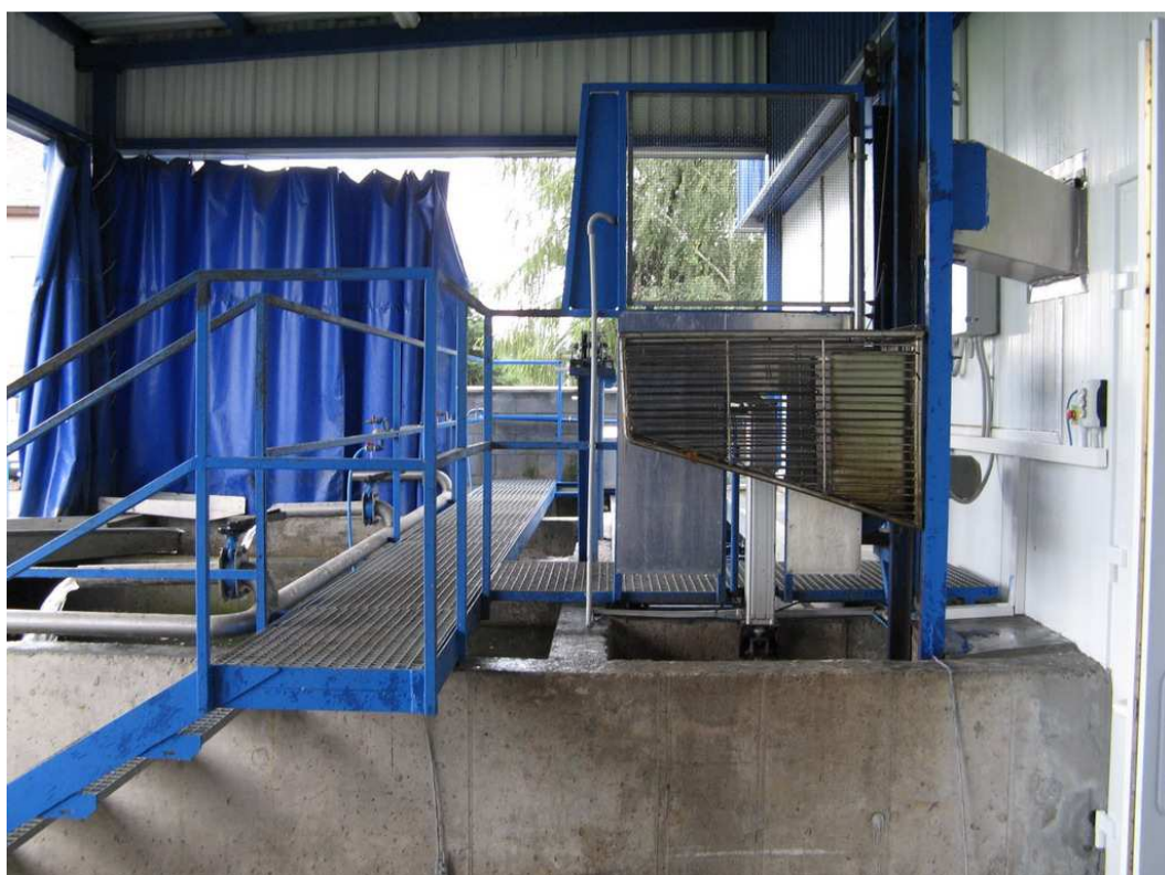
Obr. č. 13: Výtah pro nakládku ryb a přepravu do zabíječky
