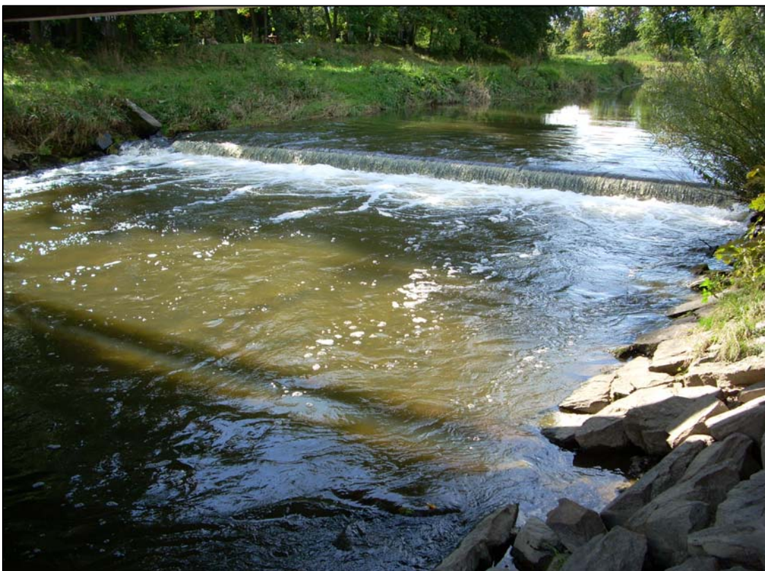
Obr. č. 4: Příčná překážka na toku zabraňující úniku ryb proti proudu při odlovu.
