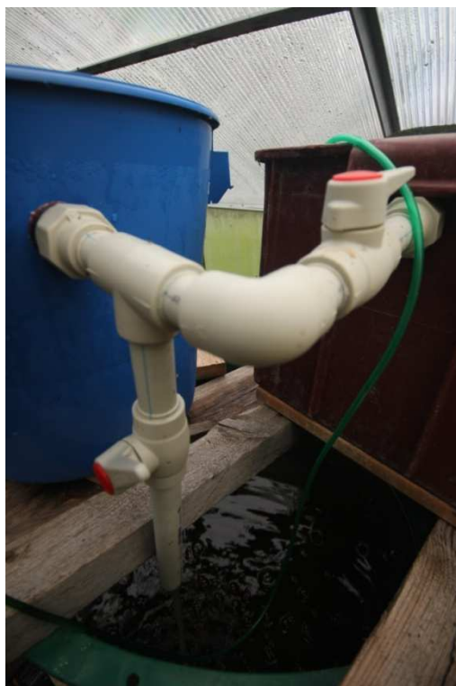
Obr. 38. Detail spoje rozbočovače a ventilu (vlastní foto)
