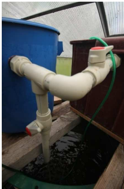
Obr. 47. Detail rozbočovače (vlastní foto)
