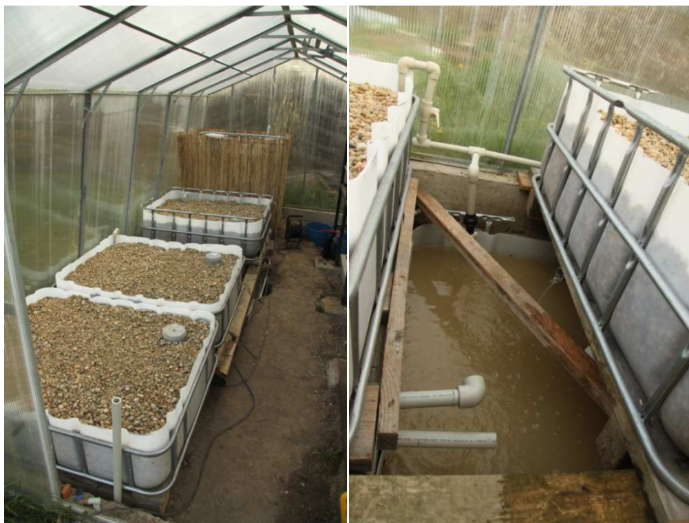
Obr. 67. Celkový pohled na Médium systém-b (vlevo), vpředu 3 záhony pro pěstování rostlin, detail umístění retenční nádrž s čerpadlem (vpravo), (vlastní foto)
