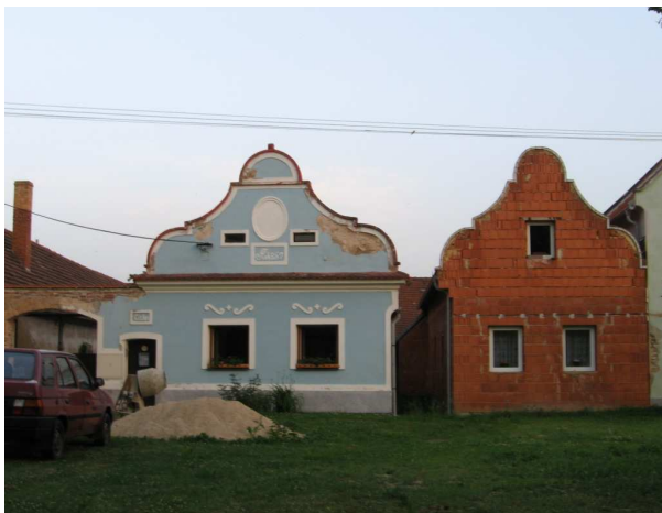
Obrázek č. 2: Rekonstrukce domu v obci Mahouš
