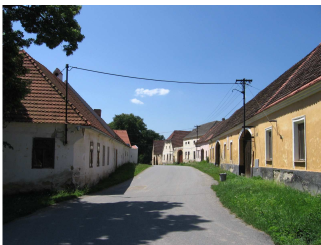
Obrázek č. 25: Komunikace protínající obec Zvěřetice
