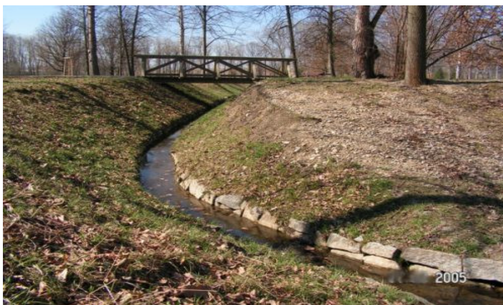
Obrázek 1- Správně udržovaný kanál
