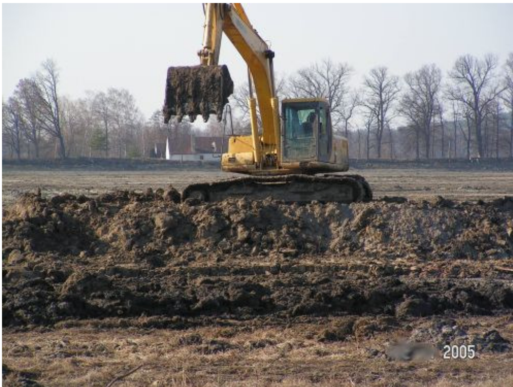
Obrázek 2- Rýpadlo provádějící nakládku splavenin
