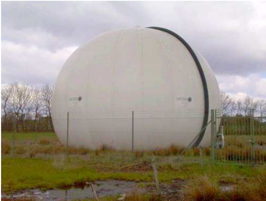
Obr.13 Kulovitý plynojem
