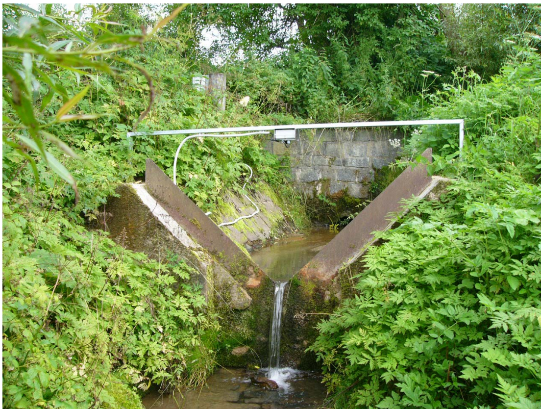
Příloha 4. Thomsonův přepad na profilu J1
