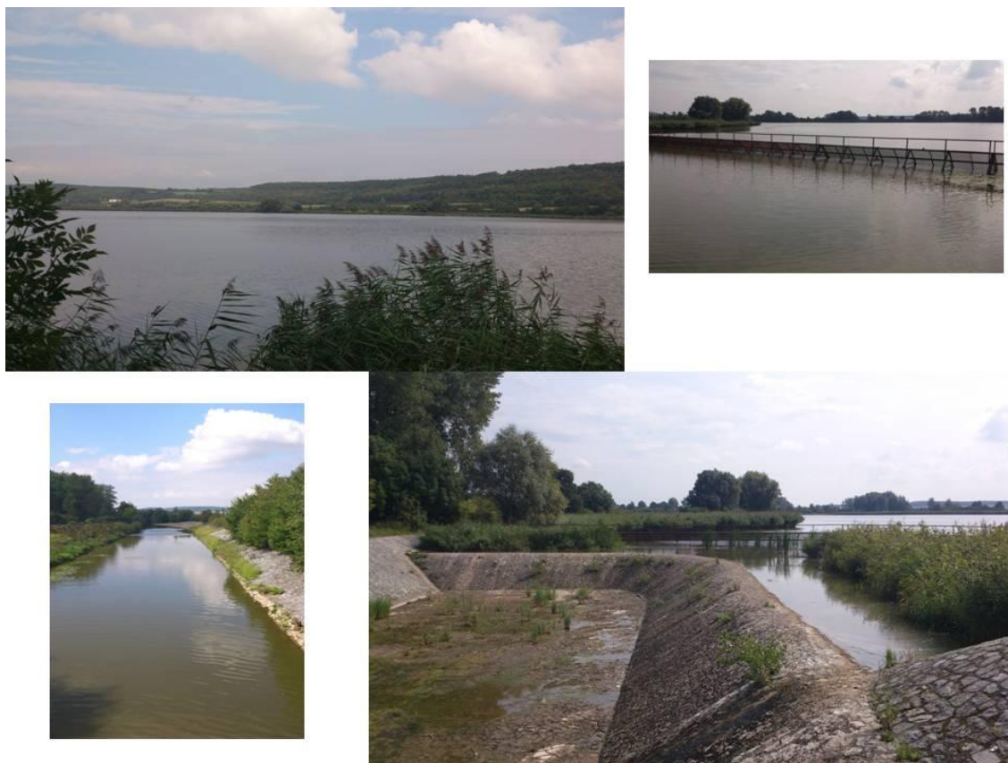
Příloha č. 6: Pohled na Žehuňský rybník, vpravo nahoře česlové hrazení nad bezpečnostním přelivem, vpravo dole bezpečnostní přeliv, fotografováno dne 28.08.2013
