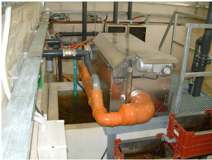
obr. 2 a 3: mechanický filtr IN-ECO
