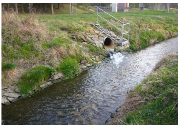
Obr. 8: Vyústění vyčištěných odpadních vod z ČOV Prachatice do Živného potoka (foto: V. Hora)
