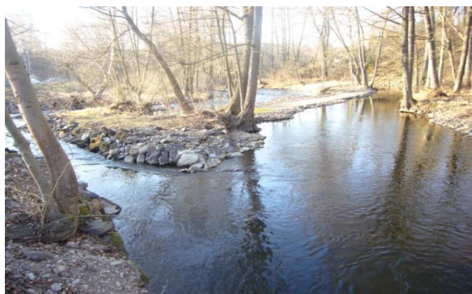
Obr. 2: Odběr vody z řeky Blanice pro MVE Husinec (vpravo náhon pro MVE, vlevo původní tok řeky)
