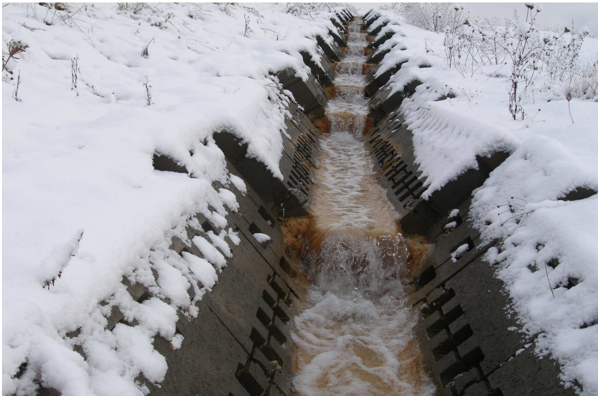
Obr.č.4: Betonové panely utvářející koryto vodních toků – nutnost dodání vegetace
