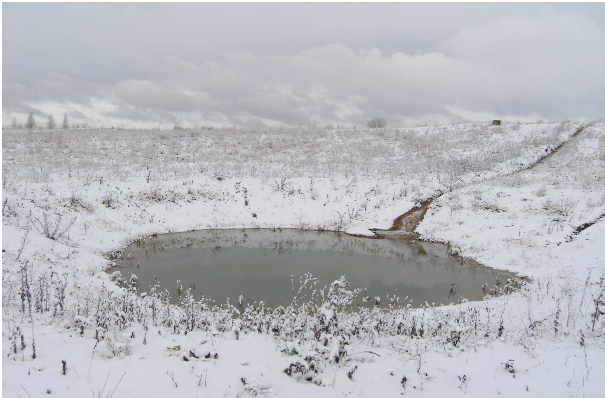
Obr.č.9: Retenční nádrže na Podkrušnohorské výsypce nad obcí Lomnice, které slouží také jako protipovodňová opatření
