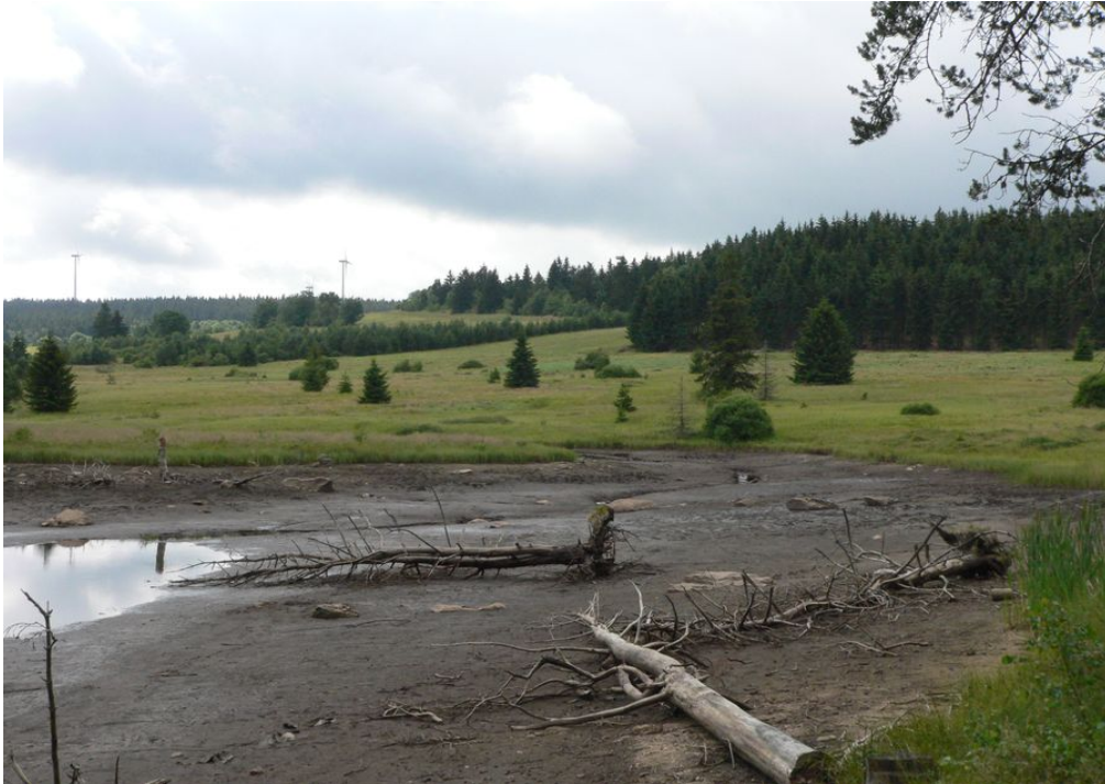
Obrázek 11 - Vodní nádrž (rybníček „U překopané hráze“) v sezóně 2007 – snížený vodní stav v době provádění oprav
