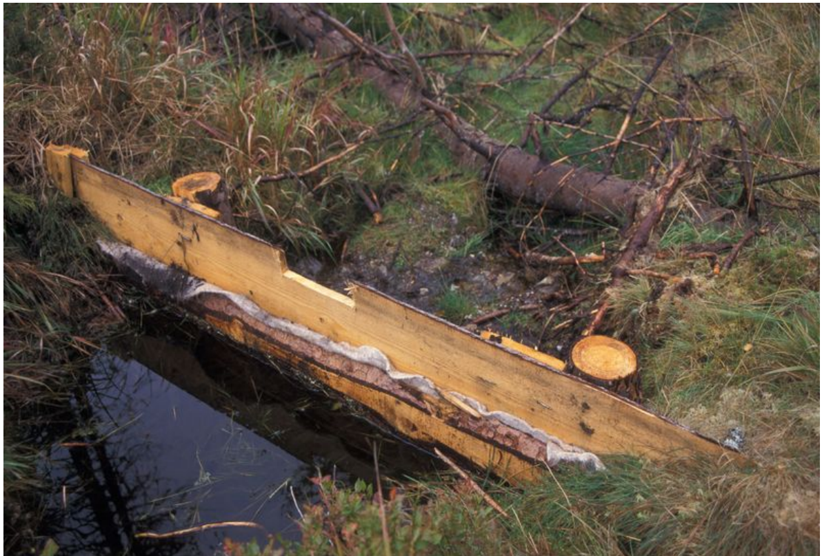
Obrázek 19 - Hráz z horizontálně ostře řezaných prken s geotextilií (ze Šumavy, 2005, foto Buřková)
