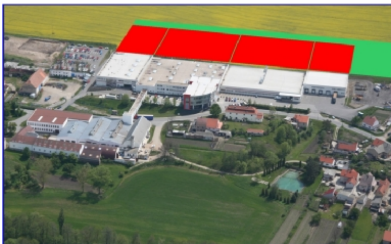
Obrázek 8: Letecký snímek sídla Linetu v Želevčicích u Slaného + plánované rozšíření výrobní haly.
