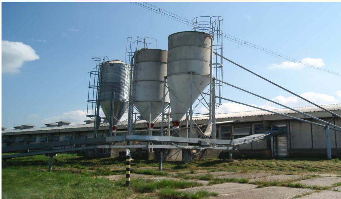
Obrázek 3 – Pohled na zásobníky krmiva a pásový dopravník na vejce u haly č. 4
