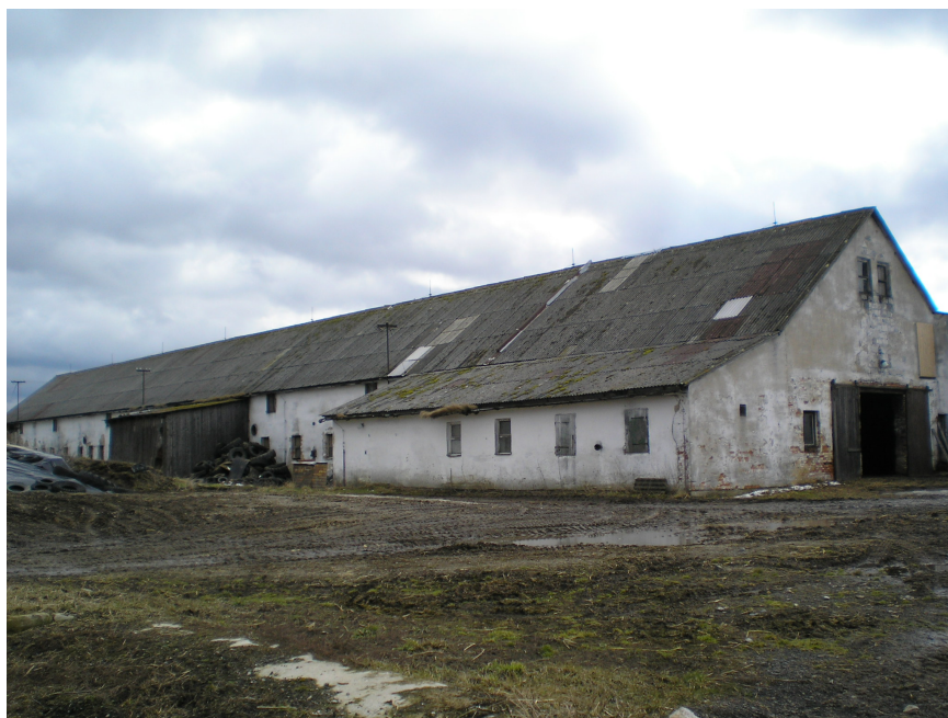
Foto 1 - Pohled na stáj - vazná stáj
