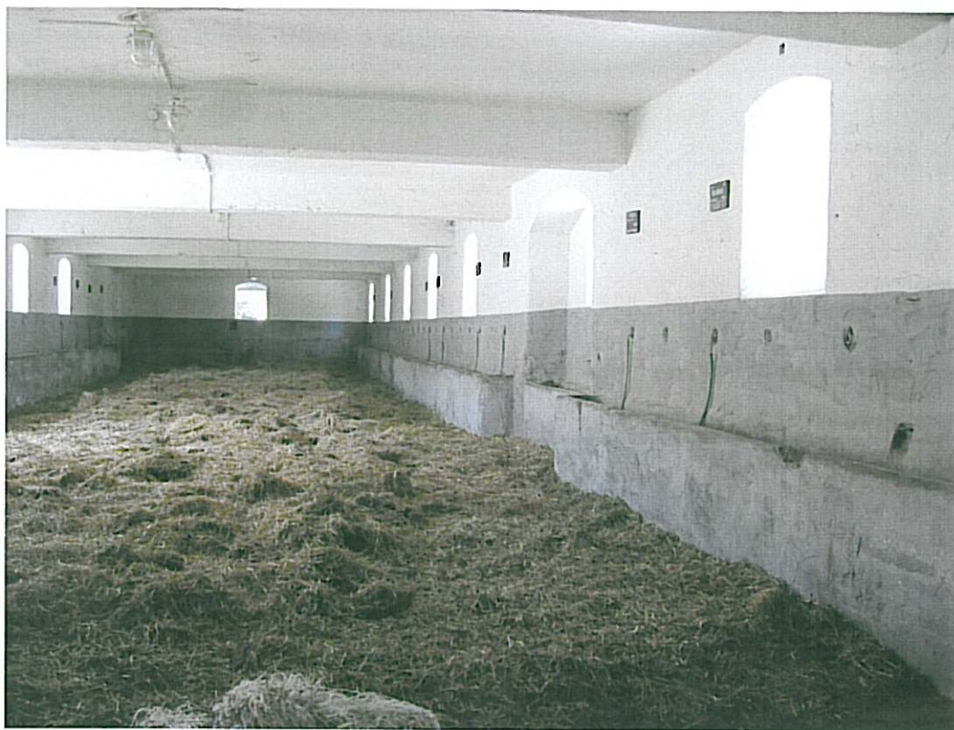
Pohled do celé stáje, kde bylo prováděno měření
