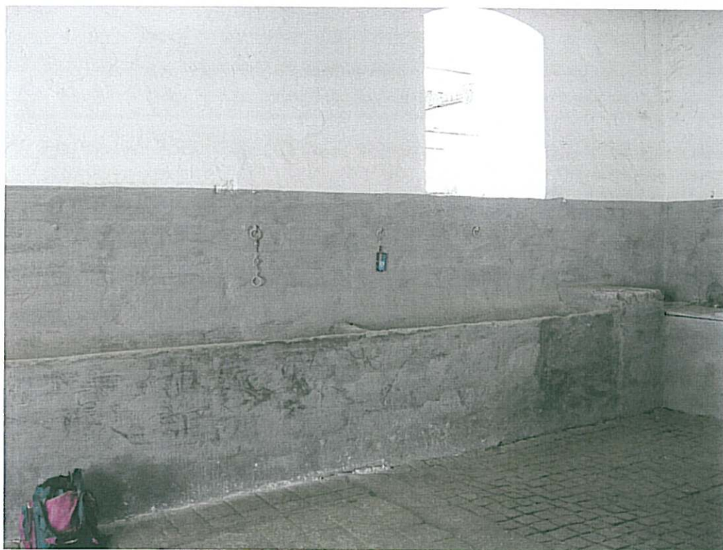
Nainstalovaný commetr ve stáji
