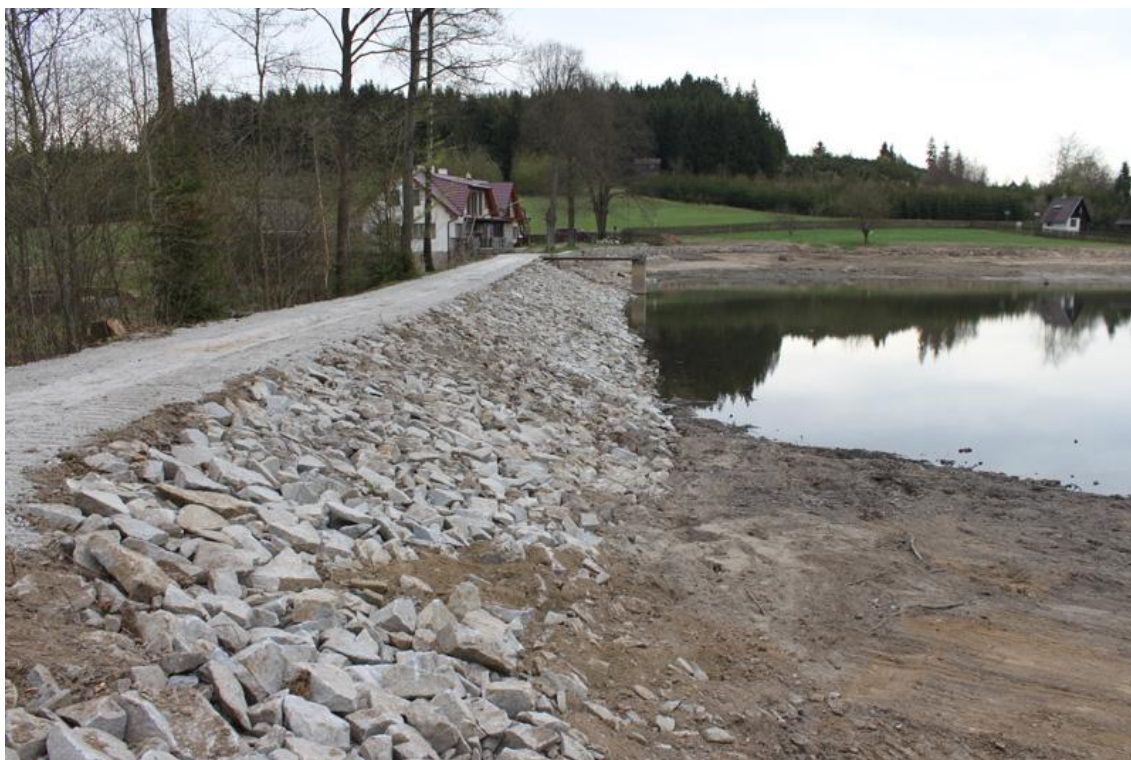
Obr. č. 18: Hráz rybníka Pařez po odbahnění
