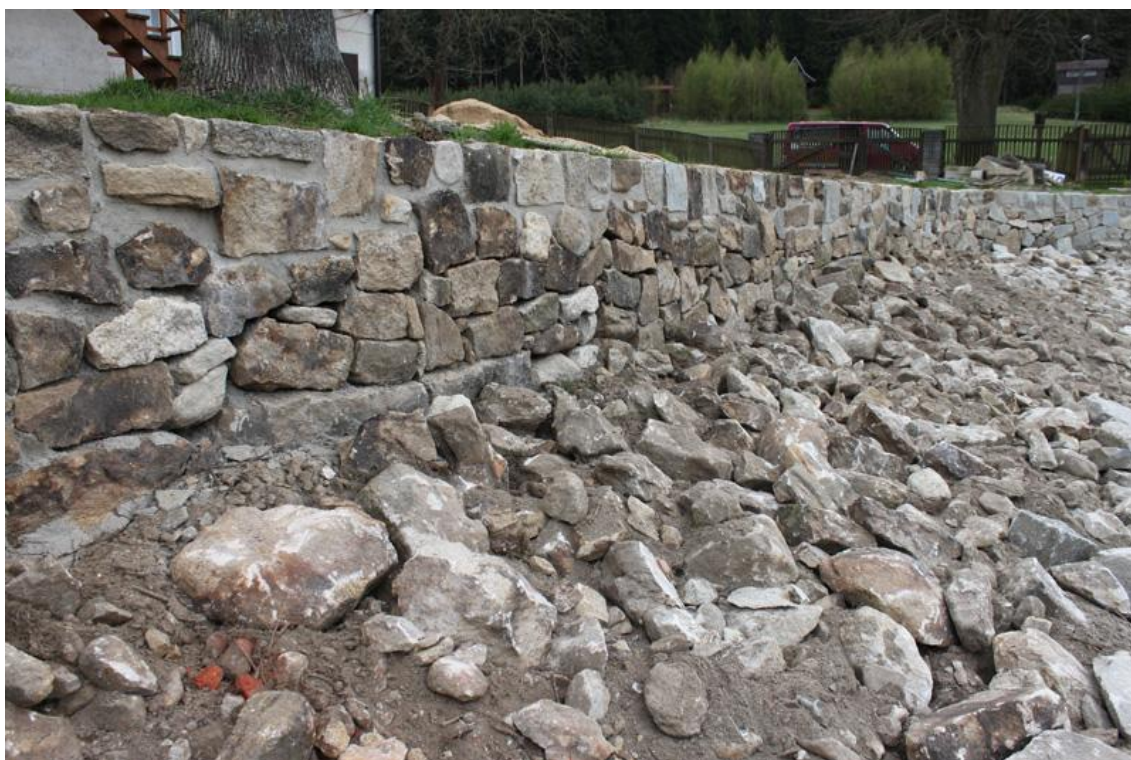
Obr. č. 19: Detail zrekonstruované hráze
