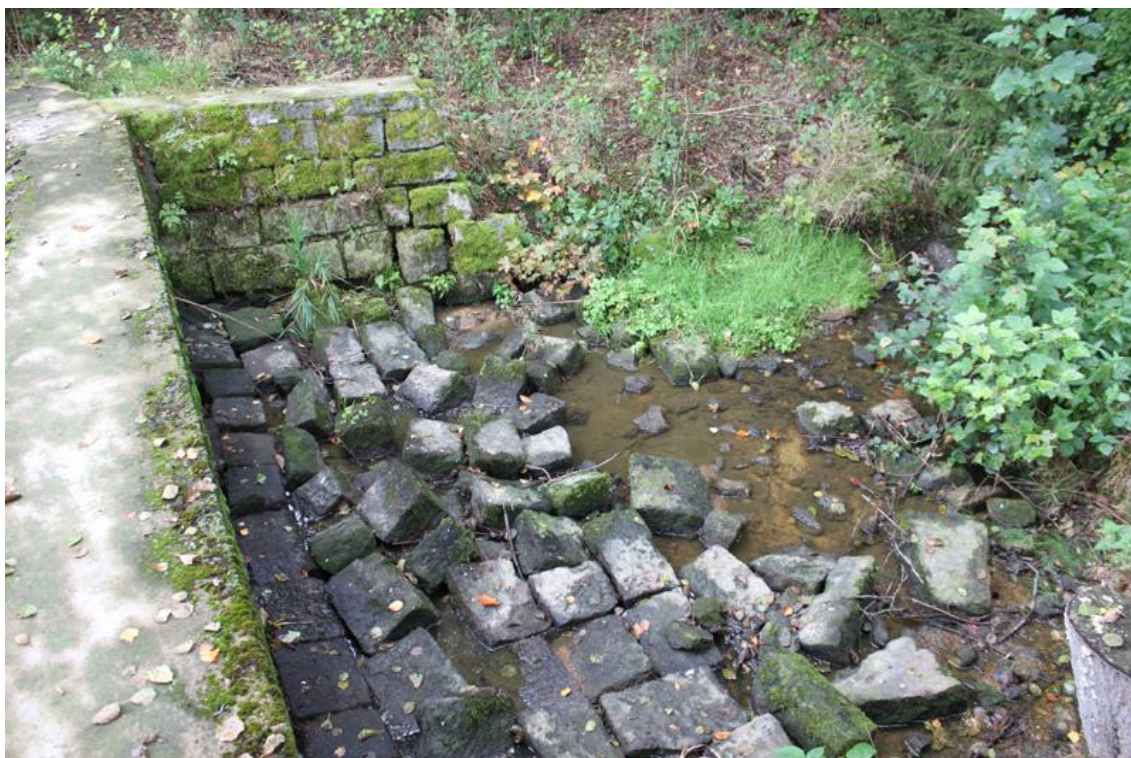
Obr. č. 4: Prostor pod bezpečnostním přelivem
