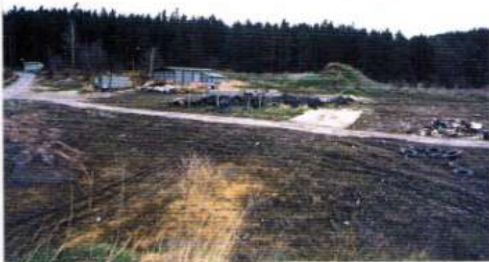
Obrázek č.2 Pohled na střední část skládky
