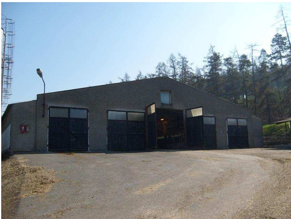
Obrázek 8.1.2. Čelní pohled na stáj
