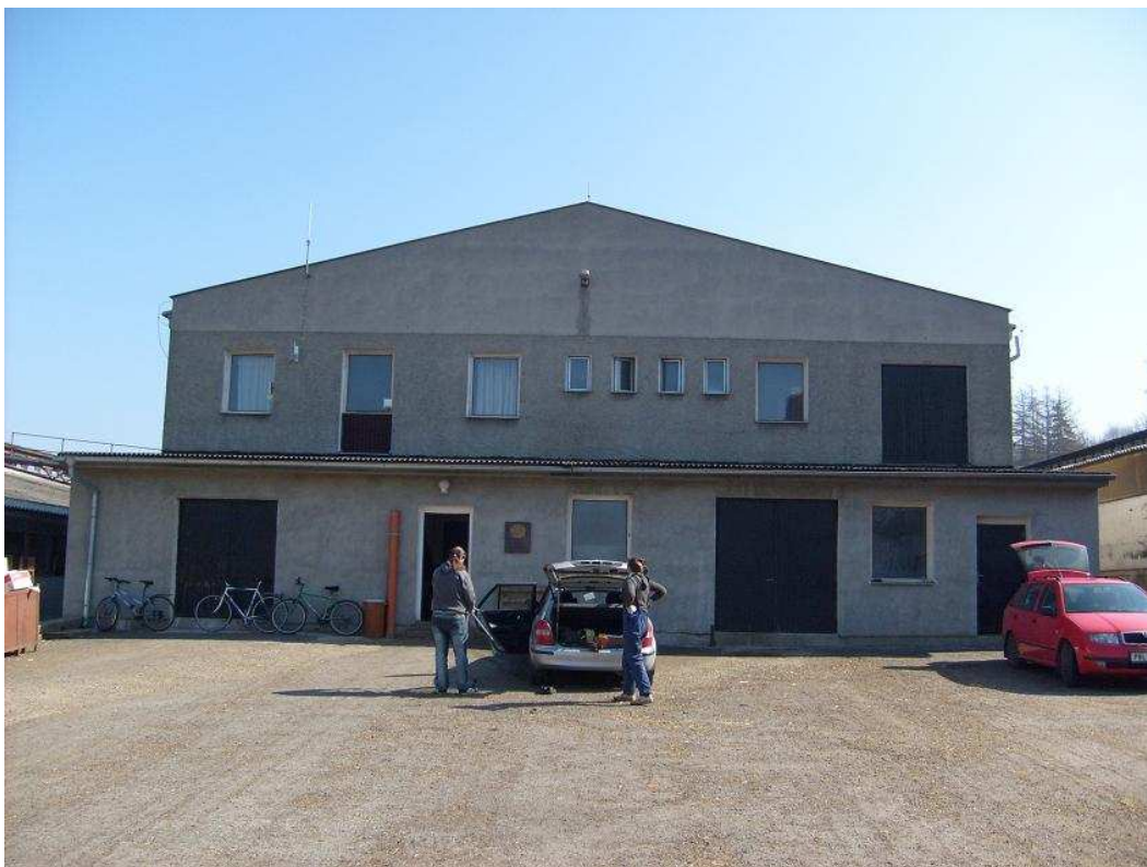
Obrázek 8.1.7. Čelní pohled na dojírnu
