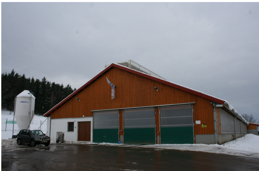
Obr. č. 4 - Novostavba pro skot
