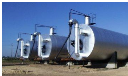
Obr. č. 13 – Kogenerační jednotky pro spalování bioplynu
