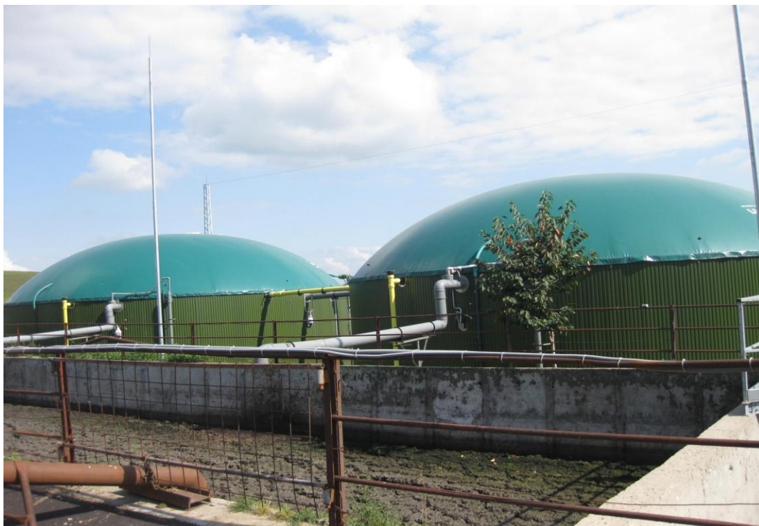
Obr. č. 41 – Pohled na fermentory (Foto:Vladimír Malík)
