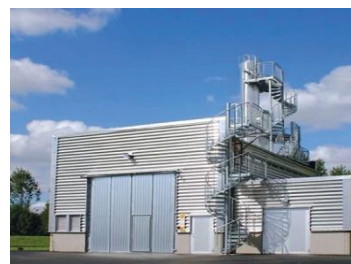
Obr. č. 12 – Stanice pro čistění bioplynu
