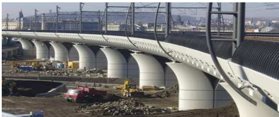
Dálnice D8 – stavba úseku Trnice – Knínice
