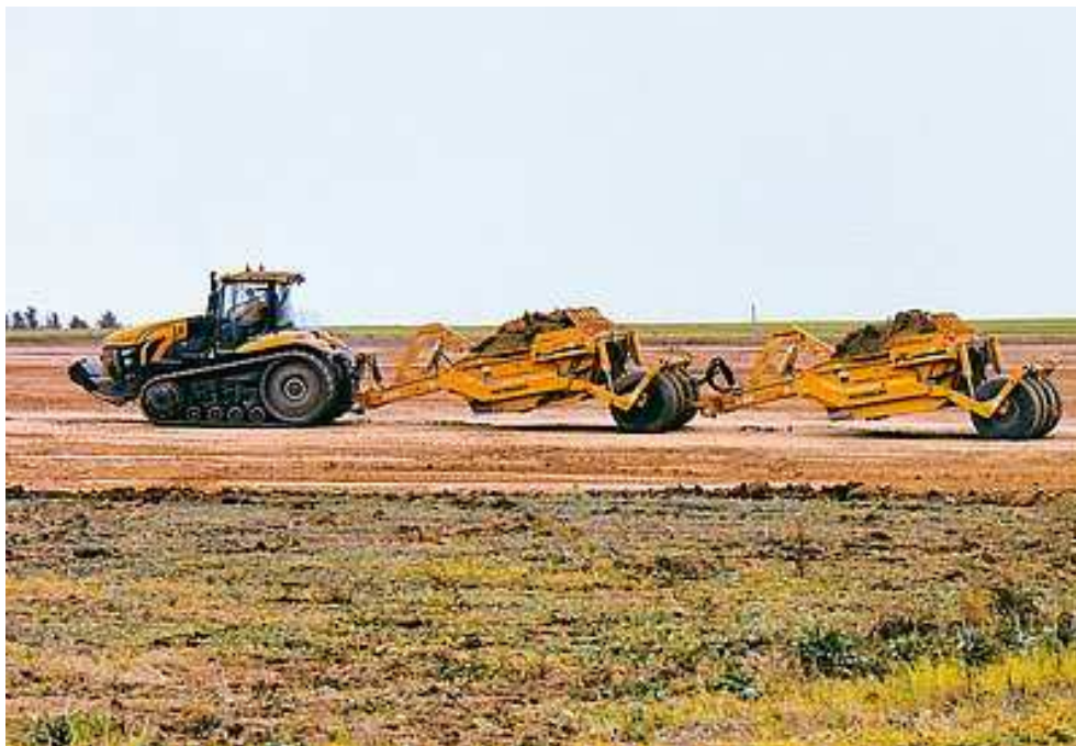
Obrázek 10 : Tandem dvou skrejprů tažených pásovým traktorem Challenger MT 875B
