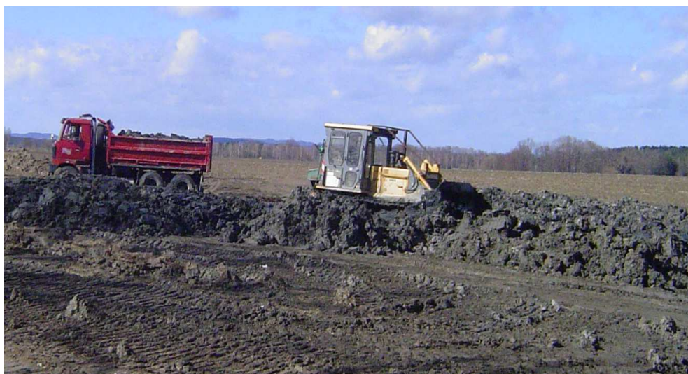
Obrázek 29 : Rozhrnování sedimentu pomocí dozeru
