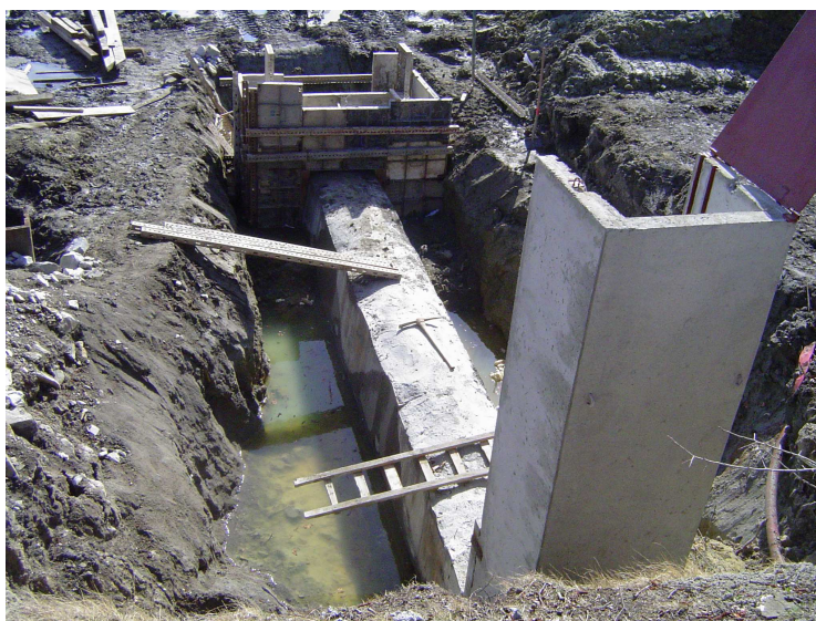
Obrázek 30 : Výstavba nového vypouštěcího zařízení
