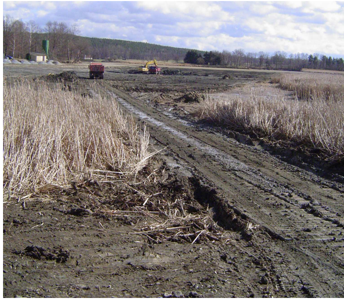
Obrázek 28 : Zhotovená cesta z ocelových panelů
