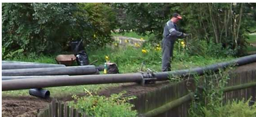
Obrázek 24 : Spojování potrubí při hydrodopravě
