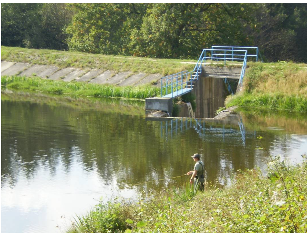
Příloha č. 13 Hráz nádrže Besednice
