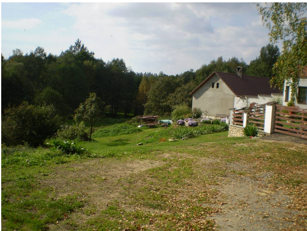
Příloha č. 23 Dům nad nádrží Mlýnek
