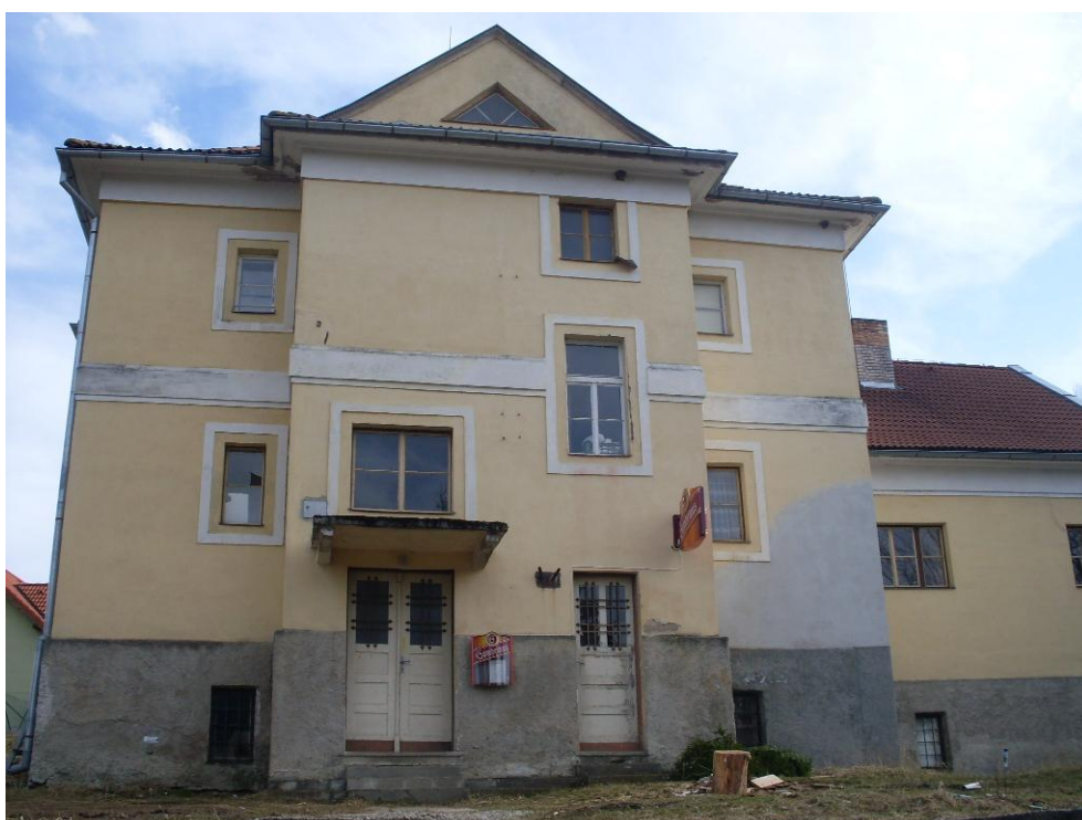
Fotografie 4 – Budova bývalé ZŠ Záblatí
