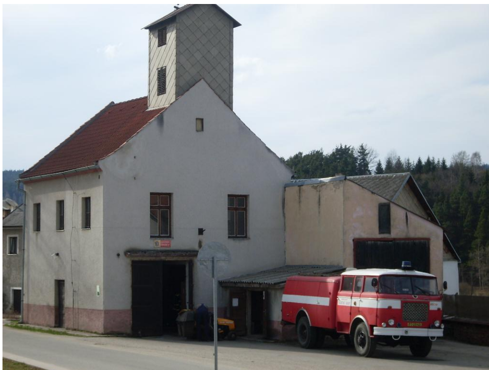
Fotografie 5 – Požární zbrojnice
