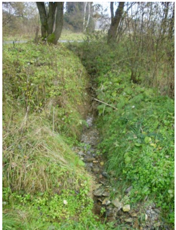
Samovolné vytvoření erozní rýhy při vyšších srážkách
