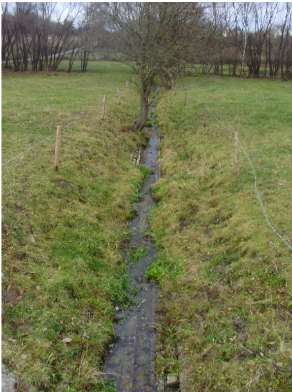
Kanál z betonových panelů
