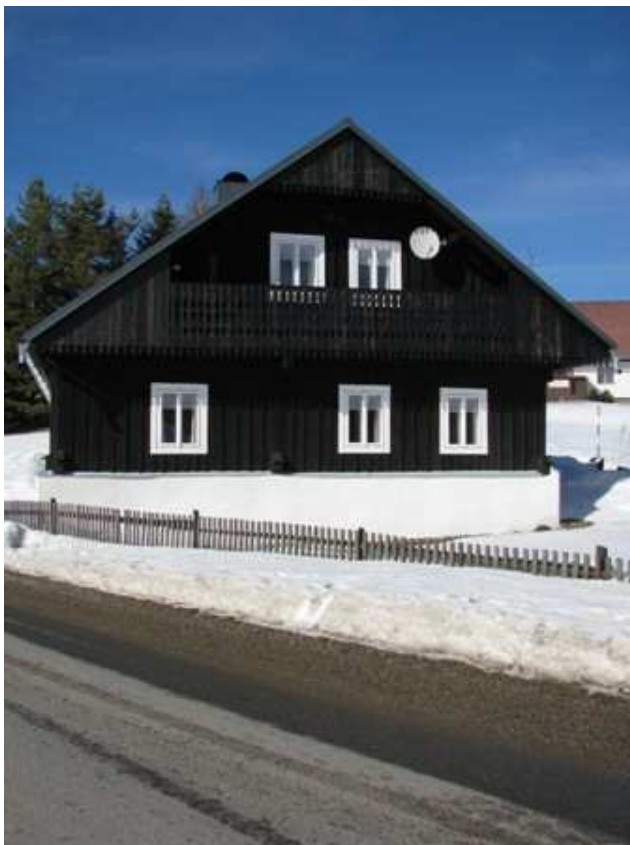
Fotografie č. 6 Pohled na renovovaný šumavský dům (pohled na jižní stranu)
