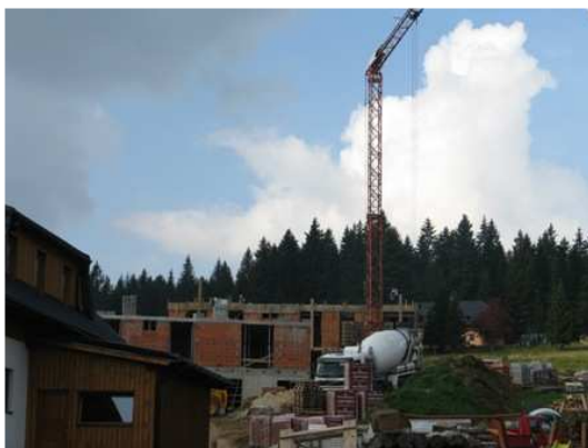
Fotografie č. 8 Započatá stavba
