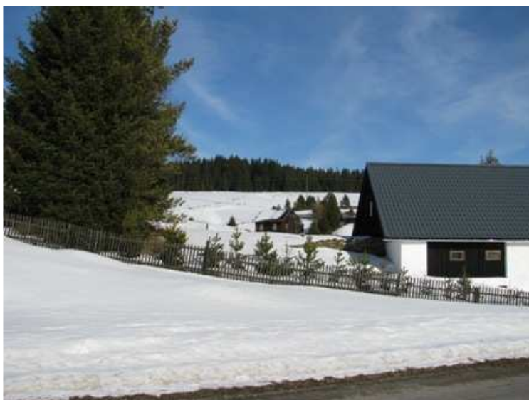
Fotografie č. 7 Pohled na renovovaný šumavský dům (pohled na západní stranu)
