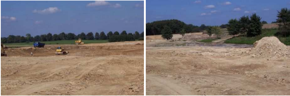
Foto č. 12 a 13: Stavba ve spodní části svahu
