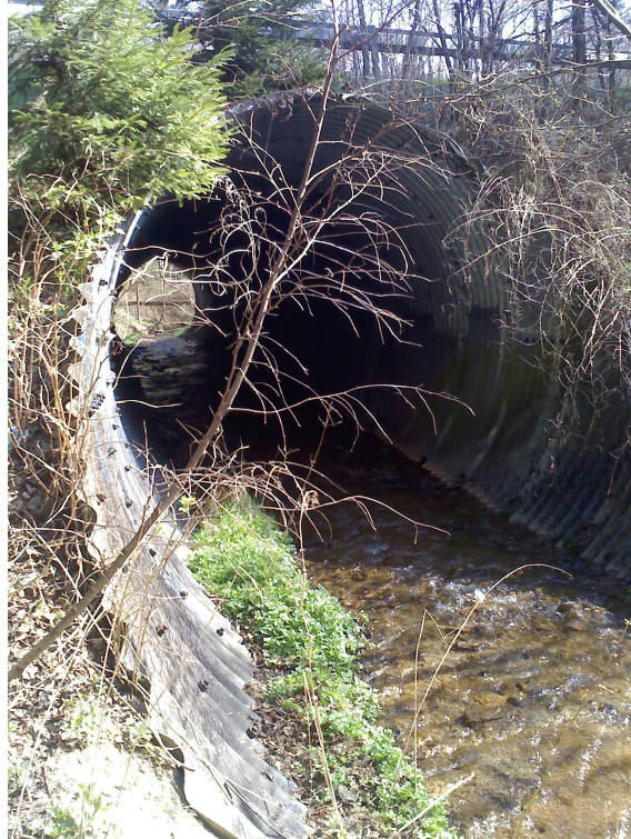
Obrázek č.3: Propustek pod silnicí číslo 157.
