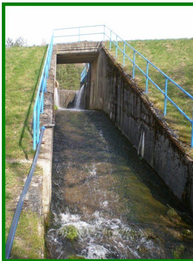
U-profil bezpečnostního přelivu a jeho skluz
