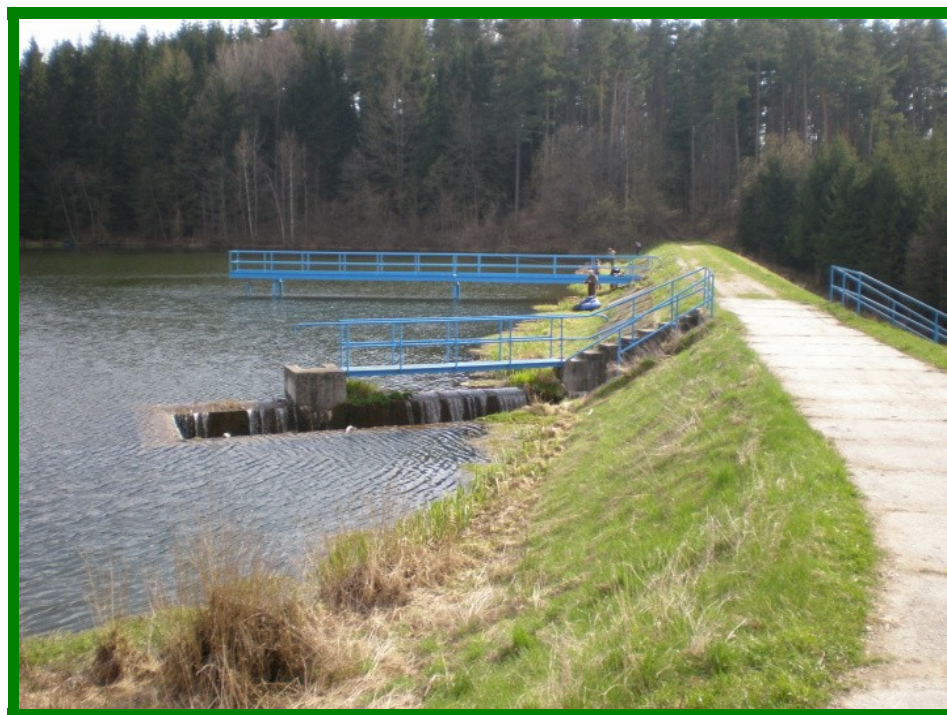
Hráz Besednické nádrže a bezpečnostní přeliv
