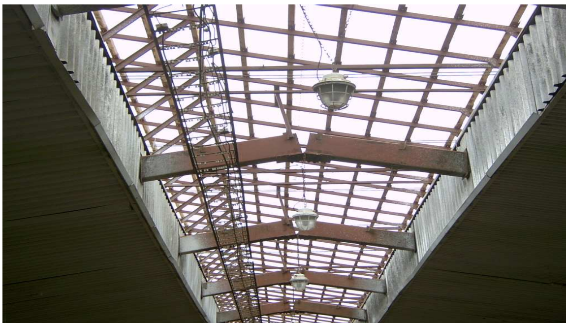
Obr. č. 14 Detail střešního větracího systému
