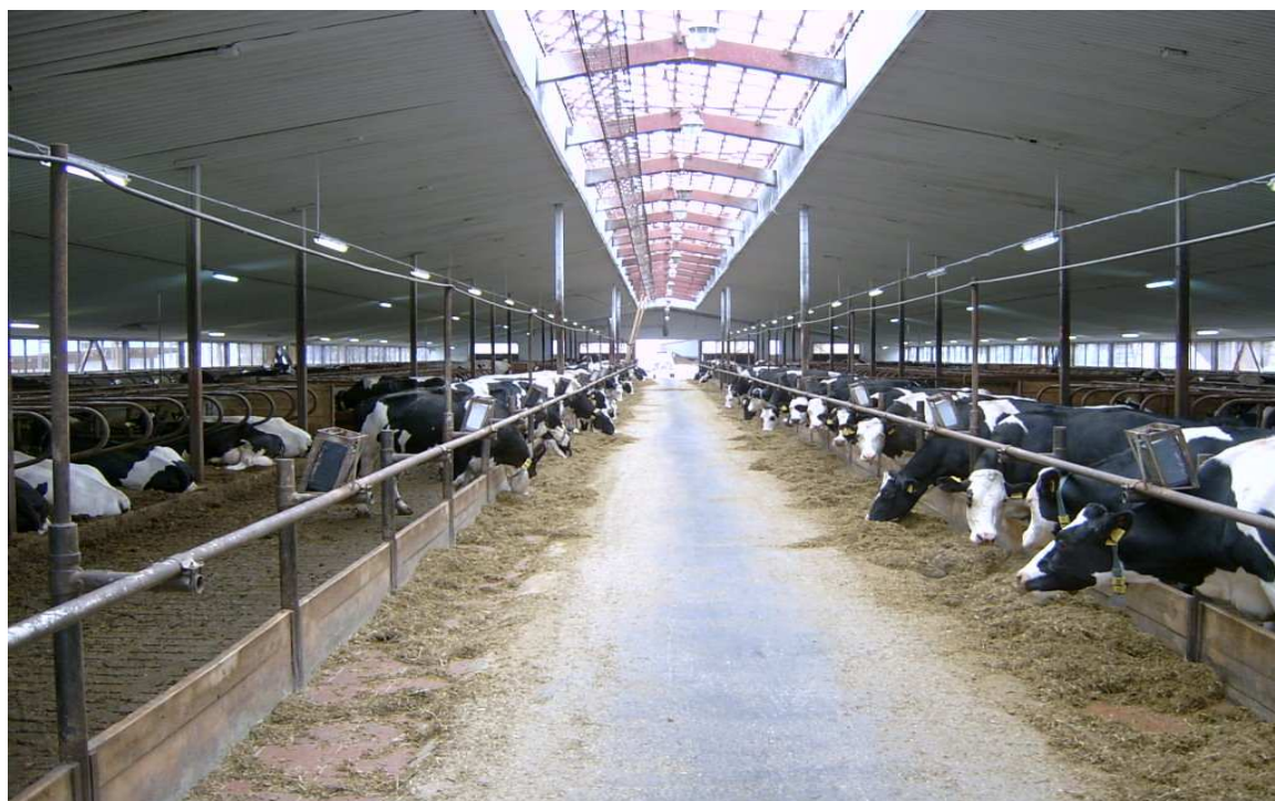
Obr. č. 11 Krmná chodba – střešní větrací štěrbin
