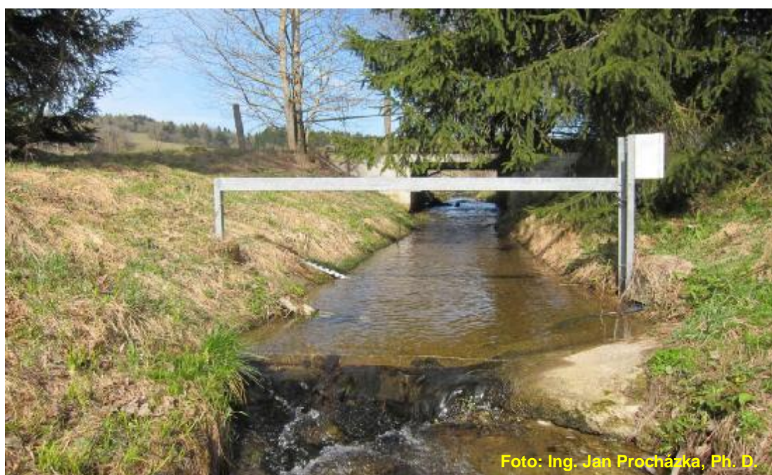
Foto č. 12: Měřicí stanice na Mlýnském potoce – betonový profil původně vydlážděného potoka
