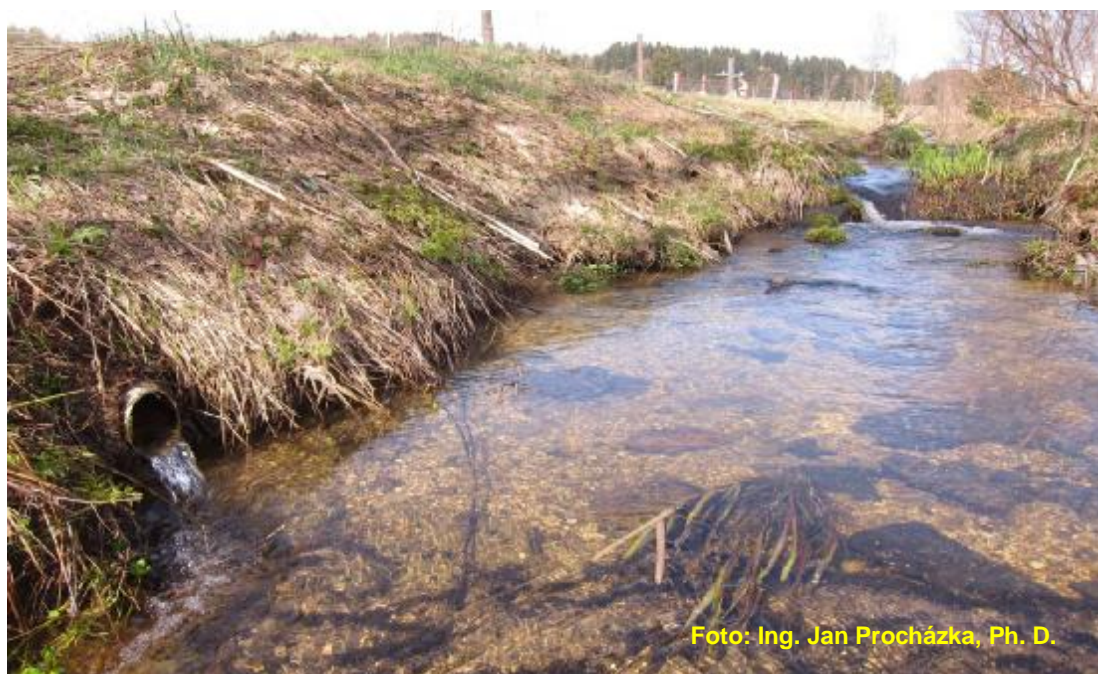
Foto č. 17: Zaústění drenážního systému do hlavního toku Mlýnského potoka
