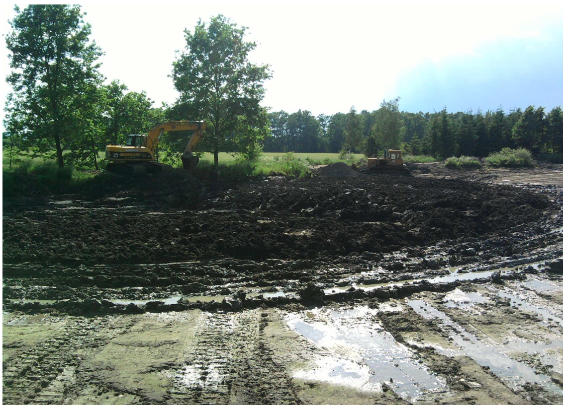
Příloha č. 2: Přibližování sedimentů pomocí dozerů
