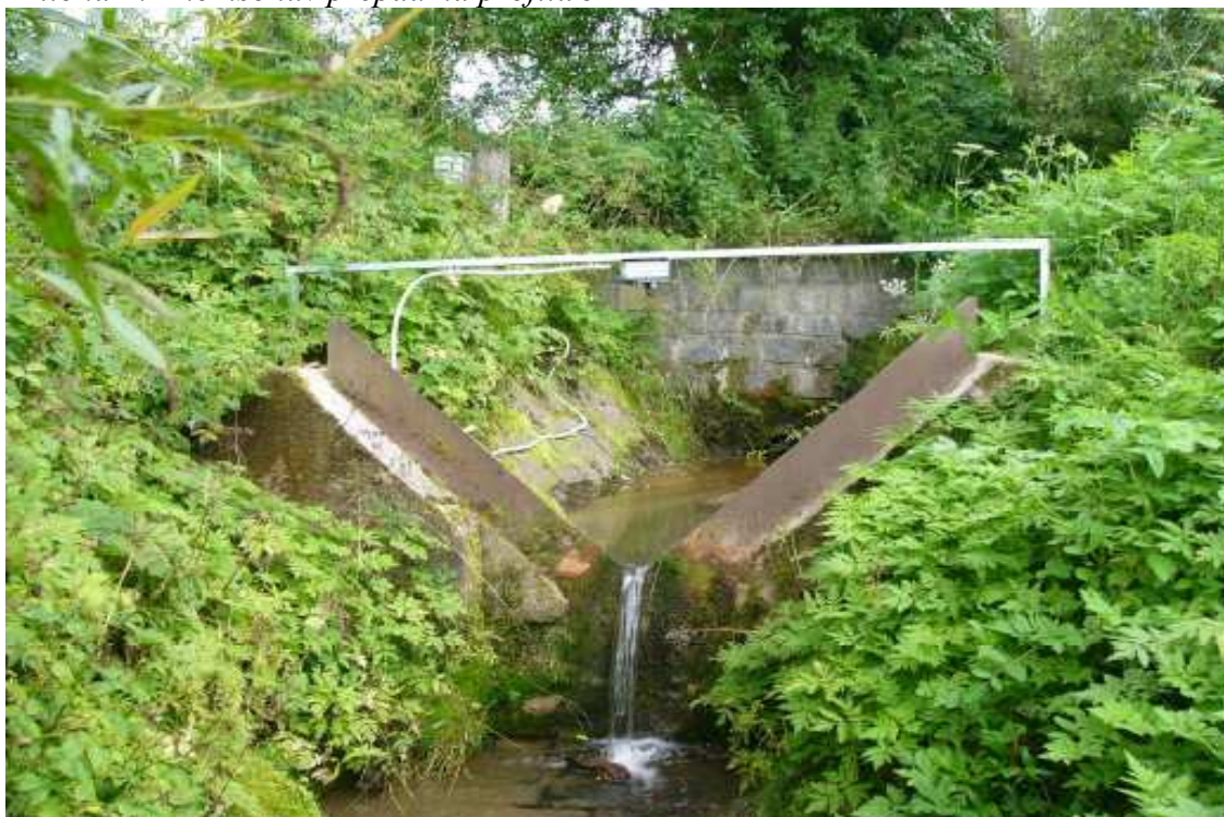
Příloha 1: Thomsonův přepad na profilu J1
