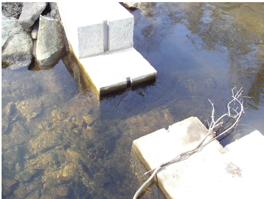
Obr 6 Výstupní betonový profil z RP
