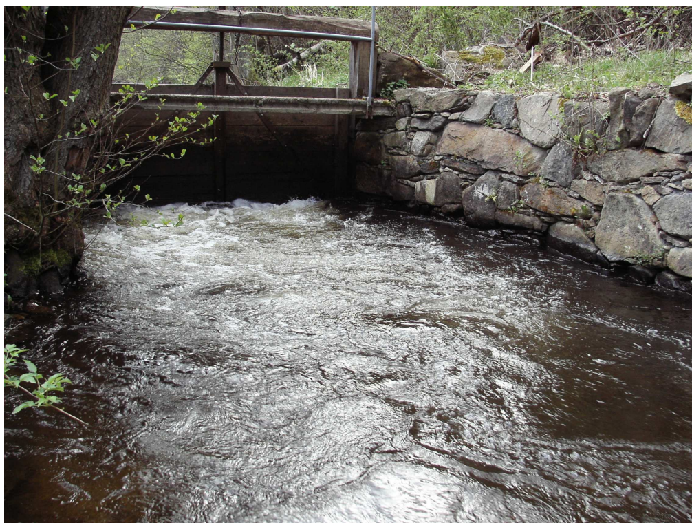
Obr 9 Turbulentní proudění pod stavidlem
