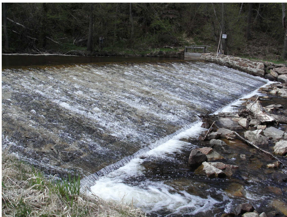
Obr 7 Jez v Zábrdí
