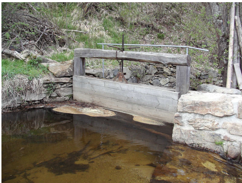
Obr 8 Stavidlo na náhonu do MVE
