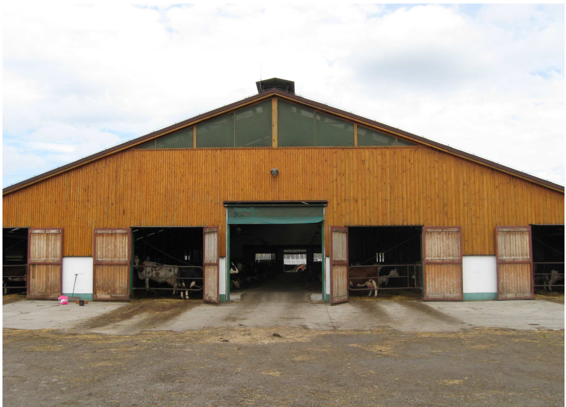
Obrázek č. 2 Krmná chodba – střešní větrací štěrbin
