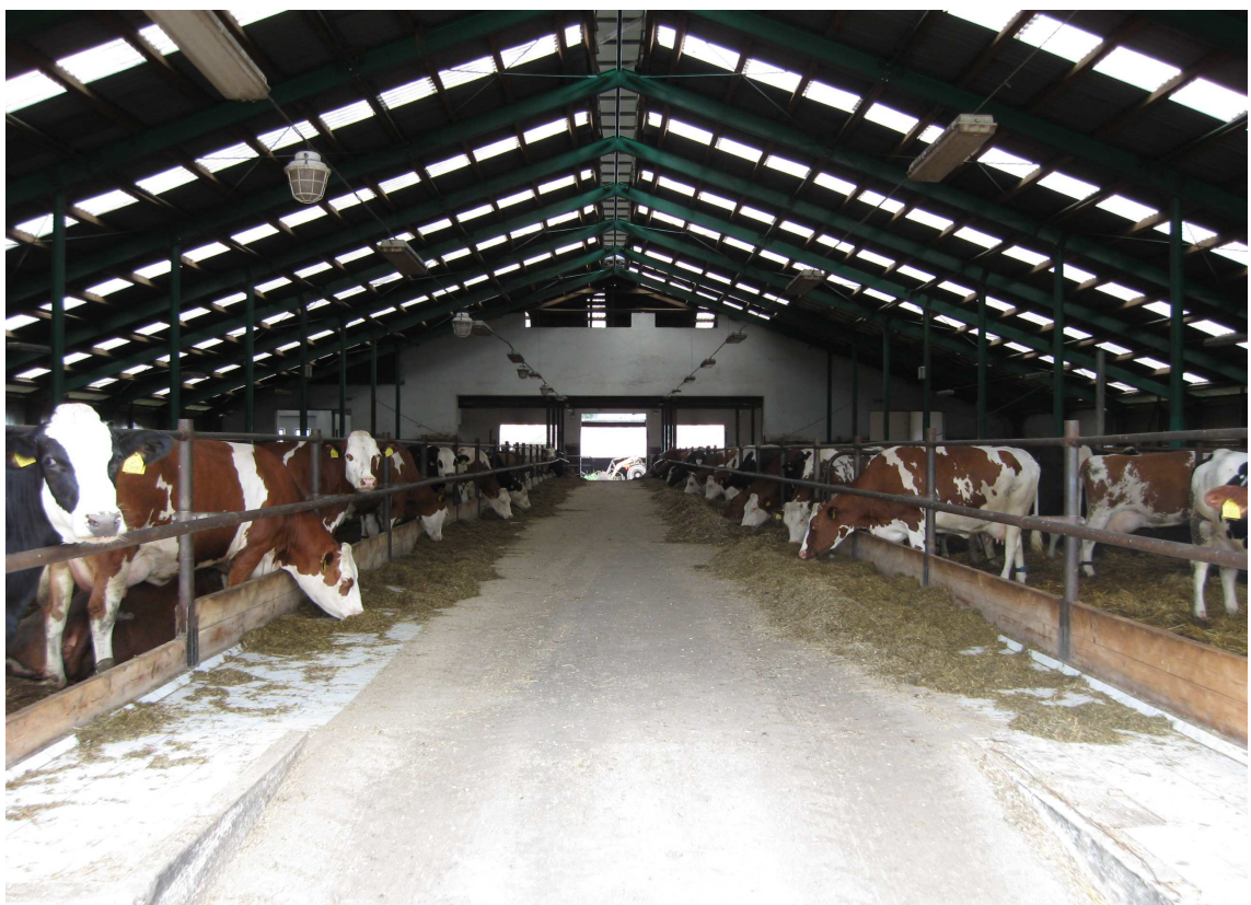
Obrázek č. 2 Krmná chodba – střešní větrací štěrbin
