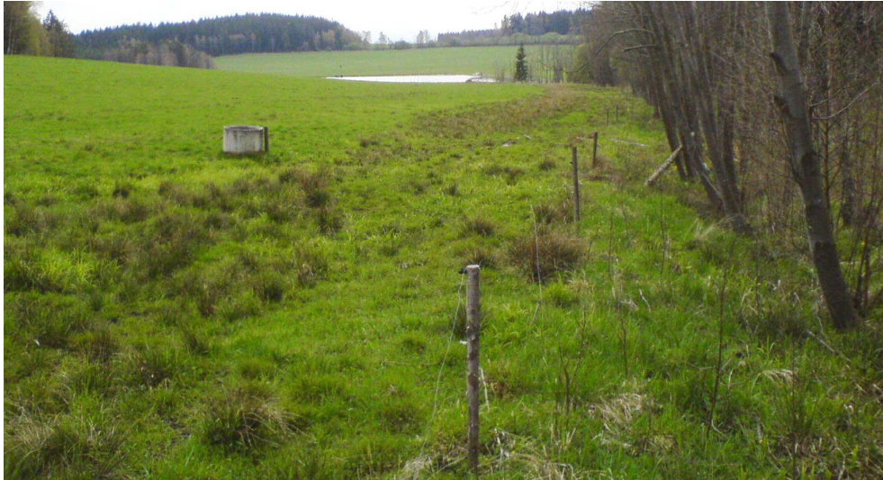
Liniové zamokření podél svodného drénu
