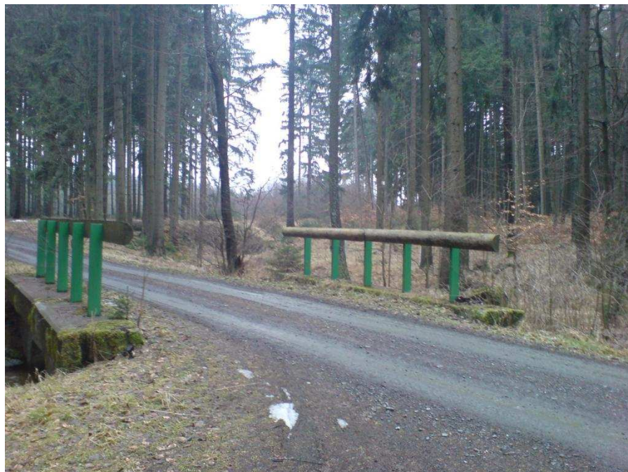
Snímek 7 - Mostek přes Teplobystrický kanál
