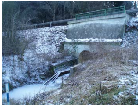
Propustek pod silnicí E55
