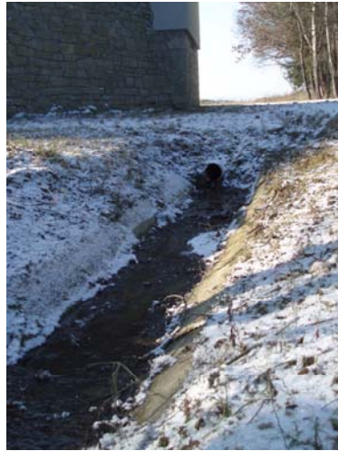
Vyústění meliorace u podjezdu pod tratí u Zvíkova
