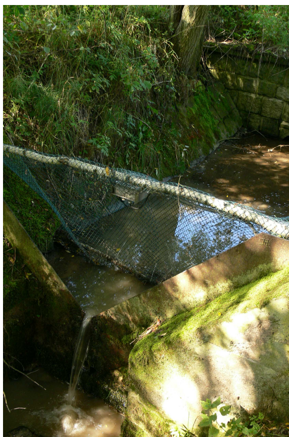
Obr. č. 3: Thomsonův přepad na profilu J2
