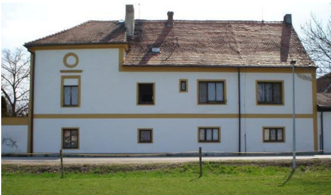
Obr. 5.12 Skutečná podoba dokumentované fasády
