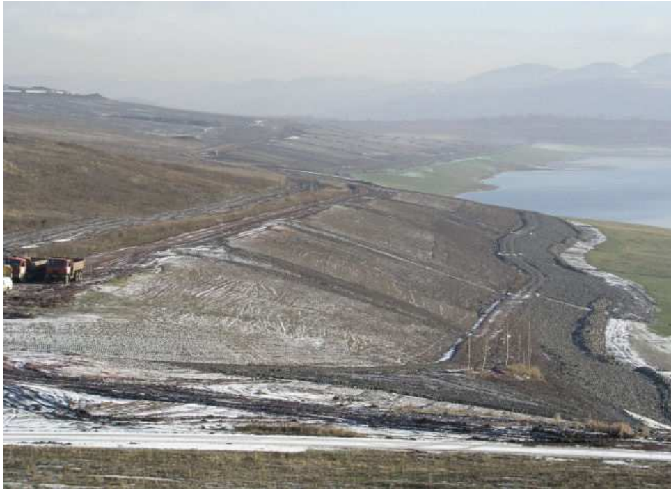
Obr. 5: Sanace svahů jezera
