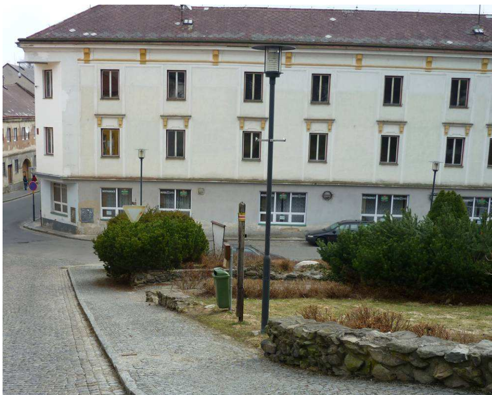
Foto č. 16: Pohled na hotel Vltava a severní stranu plochy zeleně (2011).
