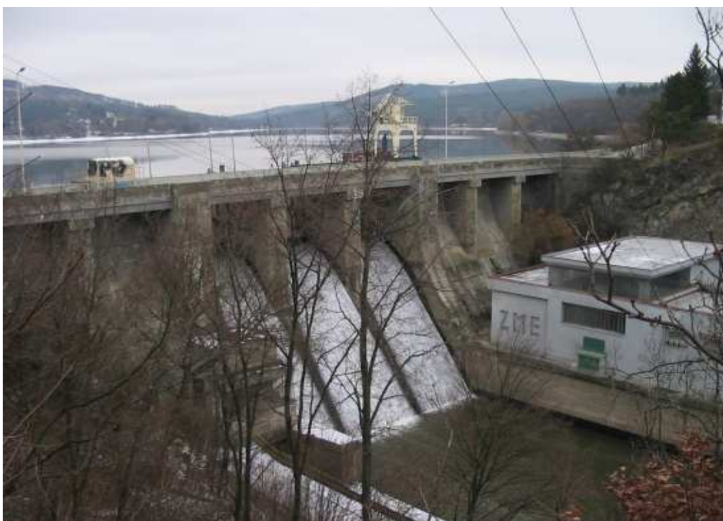
Obr. č. 2: Celkový pohled na vzdušný líc hráze a bezpečnostní přelivy Brněnské přehrady (PŘEHRADY ČR, 2006)
