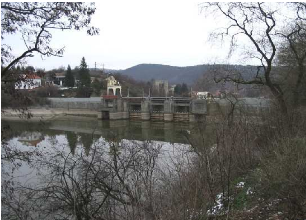
Obr. č. 1: Pohled na návodní líc hráze Brněnské přehrady
