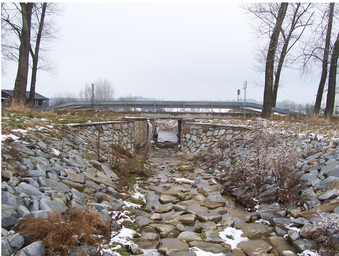
Foto č. 4: Obtokový kanál u Budějovické silnice, foto Martin Klhůfek
