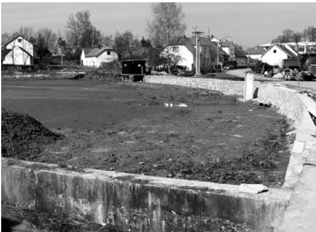
Obr. 15, Oprava hráze na Parském rybníce, zdroj: Ledenický zpravodaj r. 2010 č. 4
