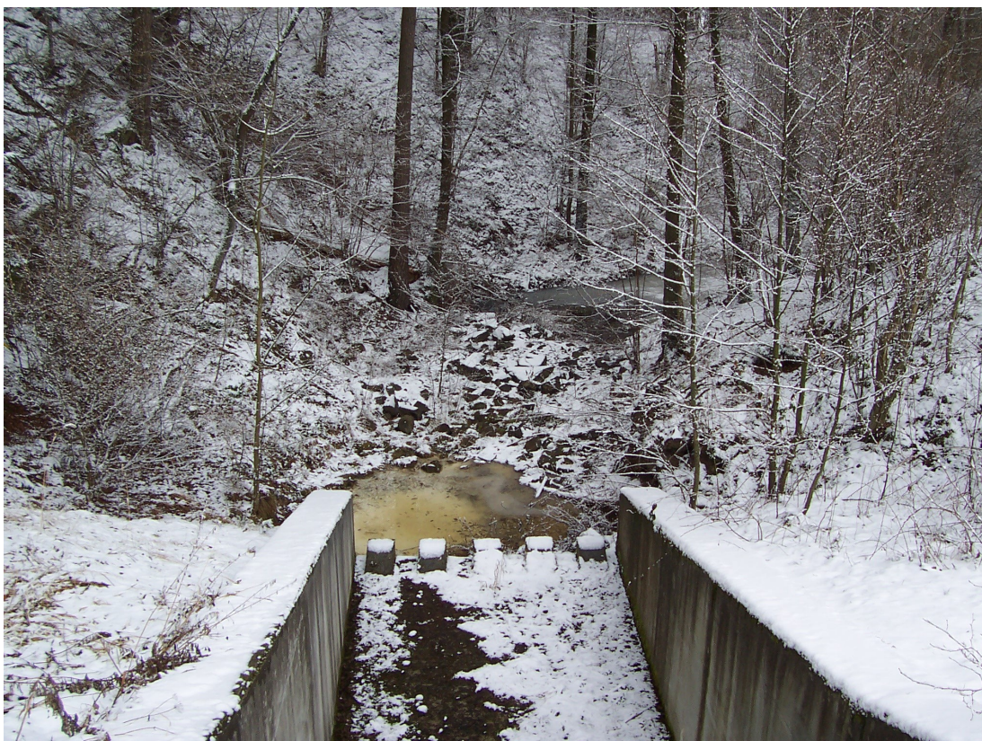
Foto č. 9: Kačerovec – vývařiště s rozražeči, foto: Martin Klhůfek
