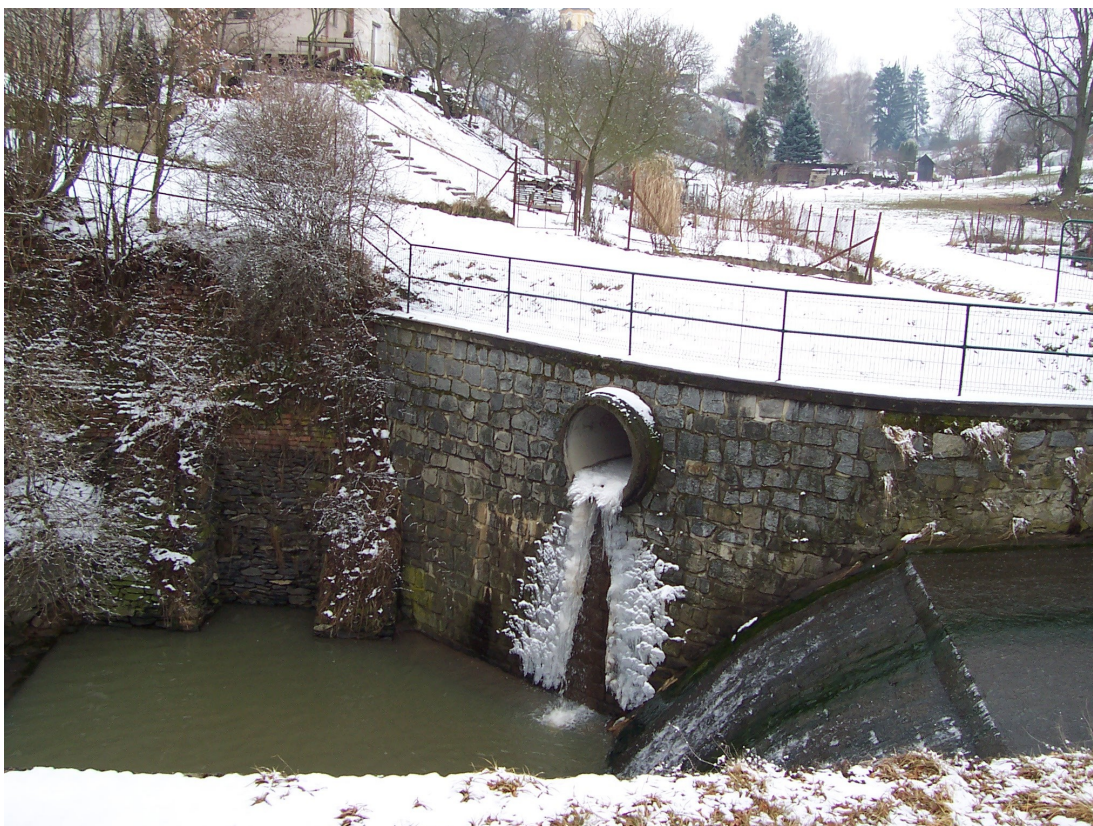
Foto č. 14: Lazna – přeliv se spadištěm, foto: Martin Klhůfek
