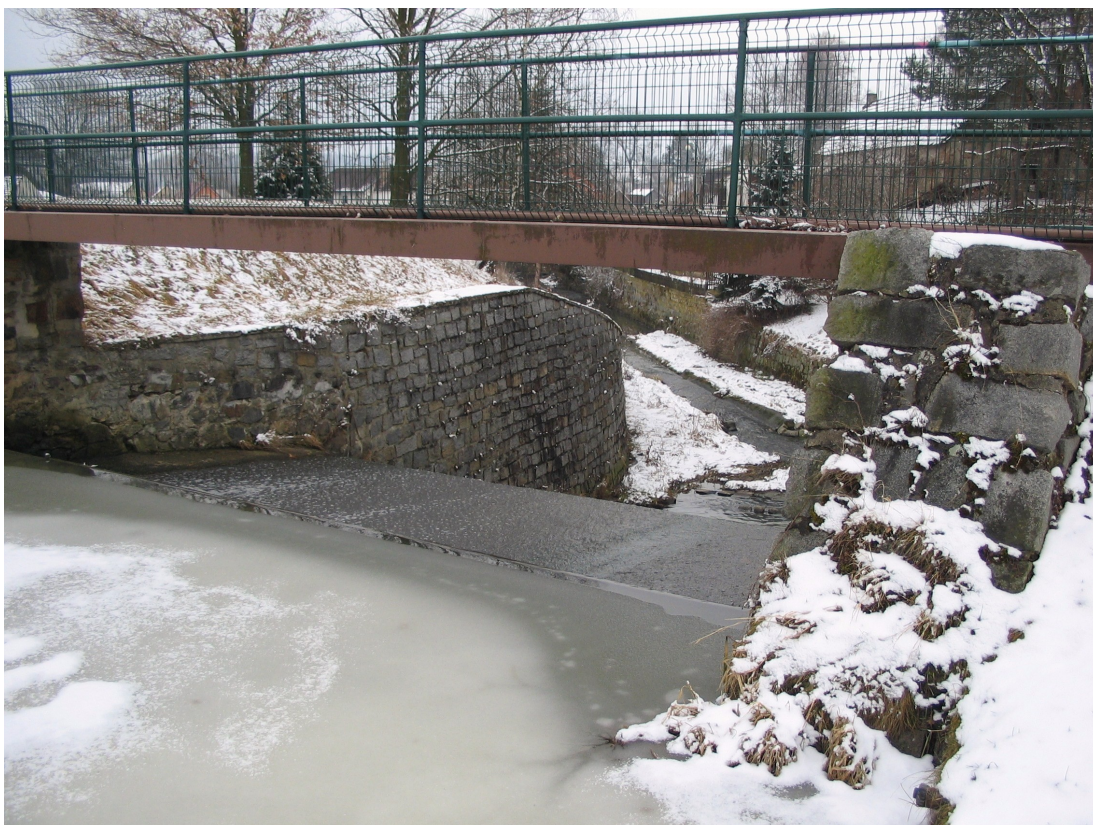
Foto č. 13: Lazna – nehrazený bezpečnostní přeliv, foto: Martin Klhůfek
