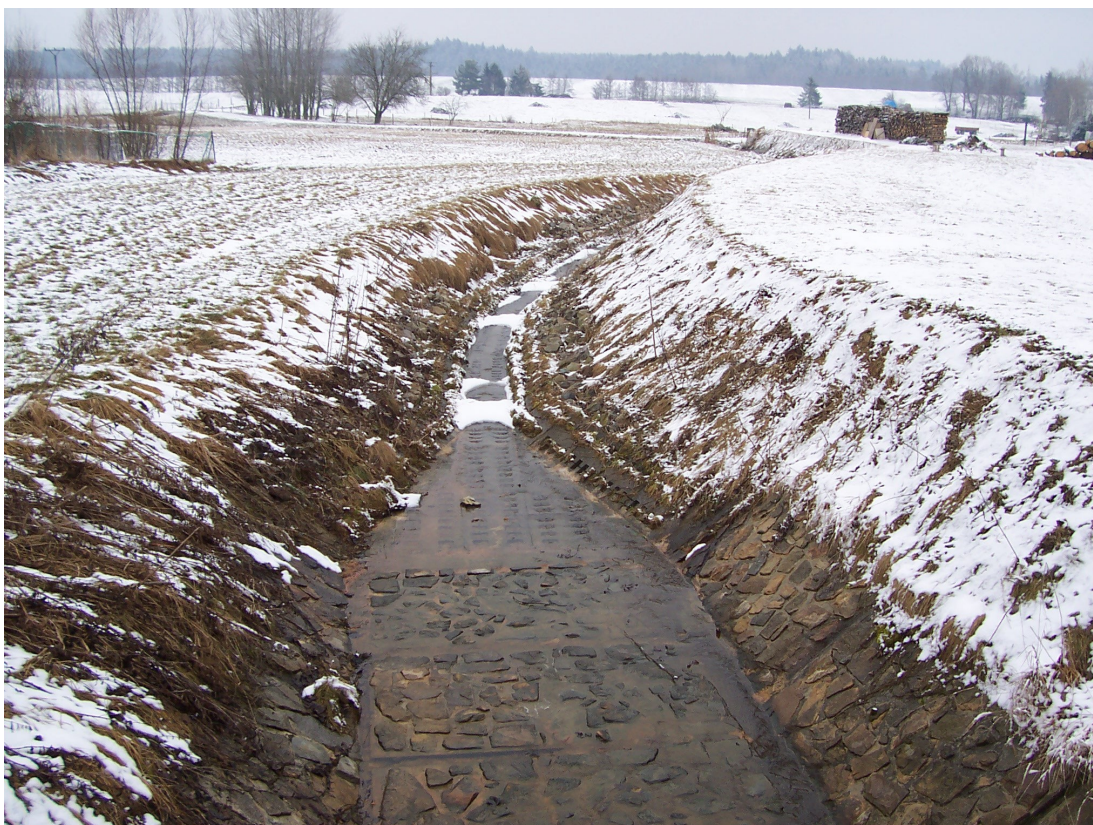
Foto č. 5: Dolní část obtokového kanálu od Budějovické silnice, foto: Martin Klhůfek
