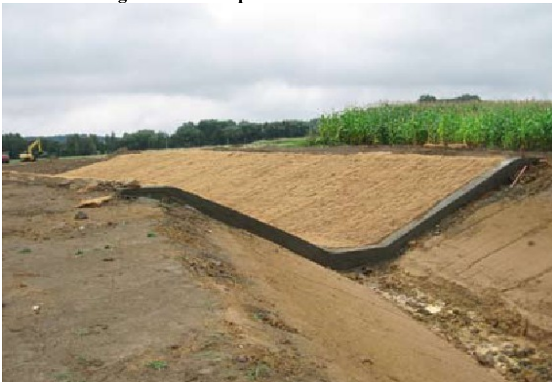
Foto č. 1: Stavba obtokového kanálu, zdroj: Modrá zpráva 2009
