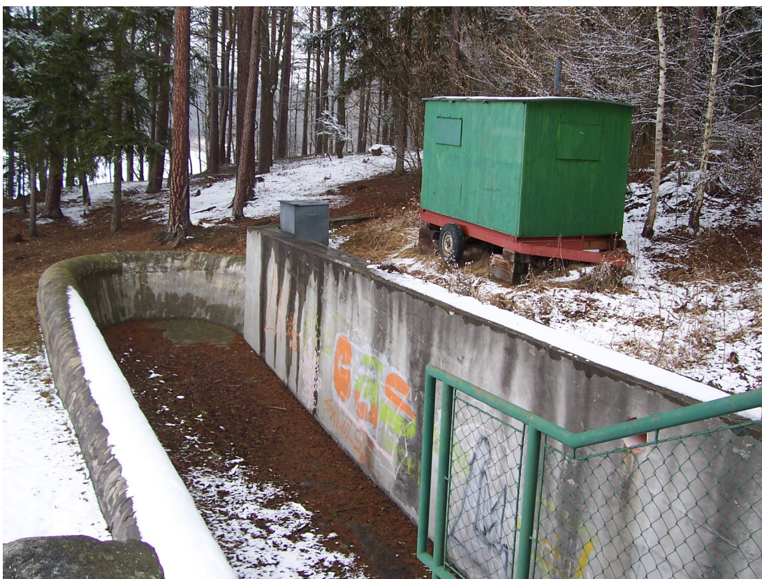
Foto č. 8: Kačerovec – bezpečnostní přeliv, foto: Martin Klhůfek
