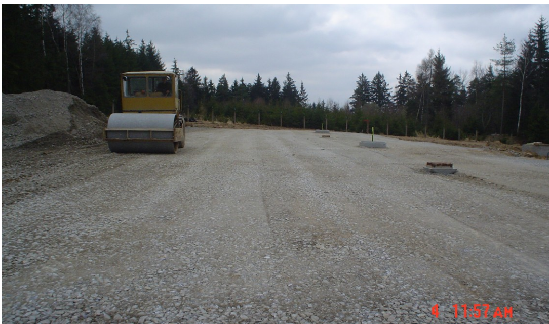
obr. č. 16 Finální úprava před pokládkou panelů
