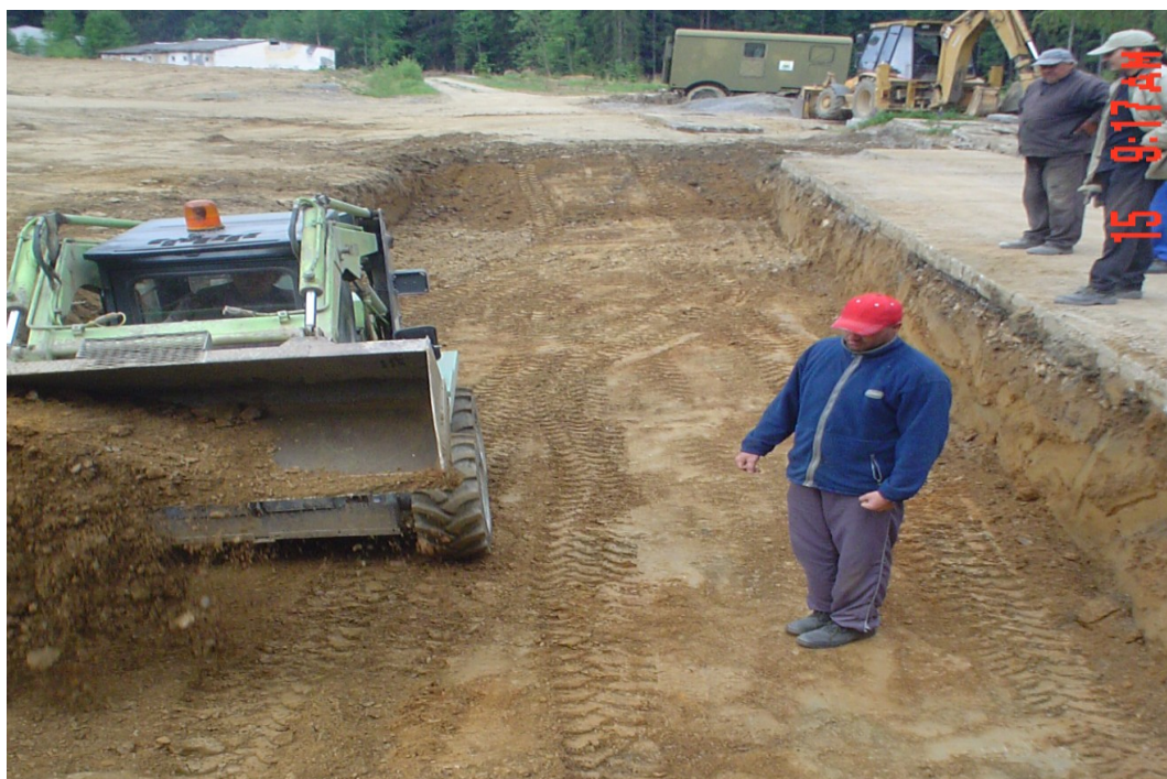
obr. č. 19 Příprava terénu pro umístění mostní váhy
