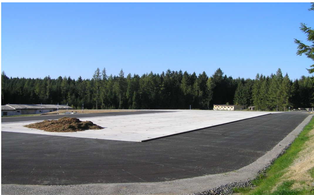
obr. č. 22 Celkový pohled na kompostárnu s první navážkou
