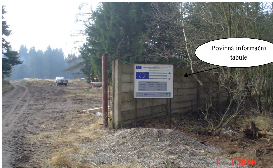
obr. č. 8 Zahájení stavebních prací na kompostárně
