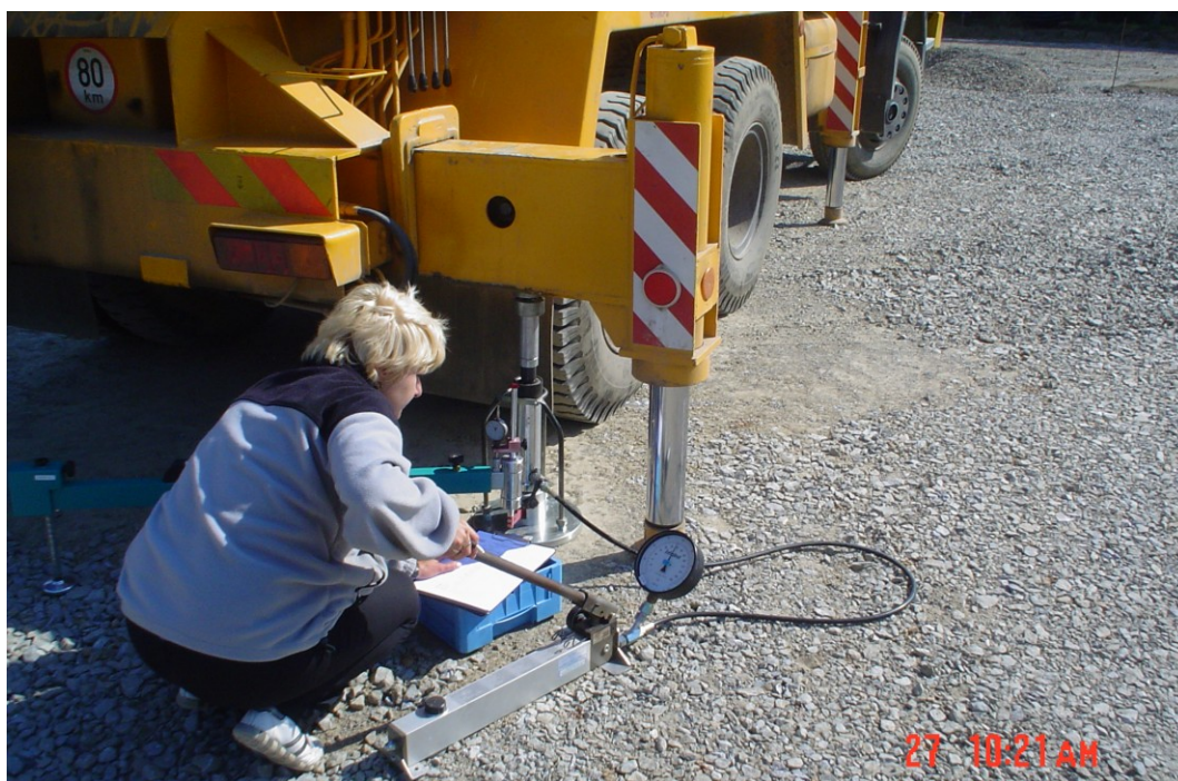
obr. č. 18 Měření zhutnění konstrukčních vrstev
