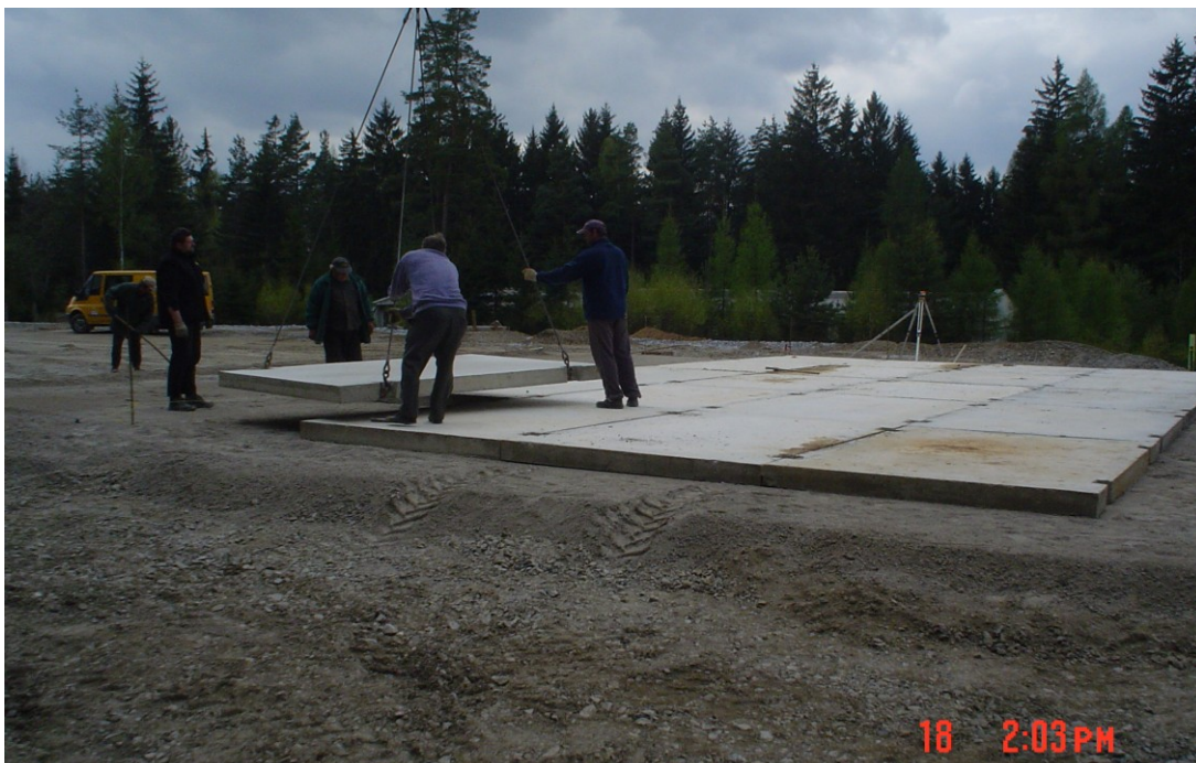
obr. č. 17 Pokládka panelů
