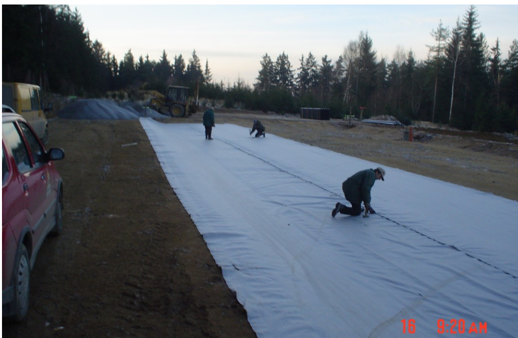
obr. č. 13 Pokládání izolační folie
