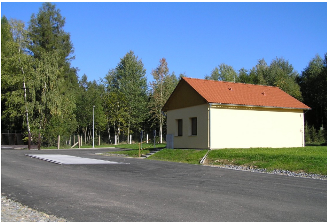
obr. č. 21 Objekt obsluhy s váhou
