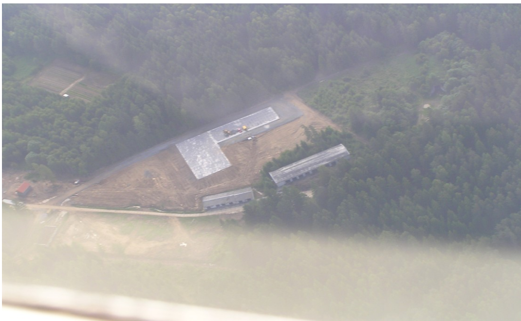
obr. č. 23 Letecký pohled na areál kompostárny
