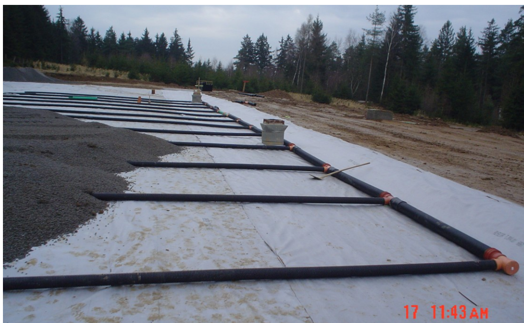
obr. č. 14 Pokládání drenážního systému z kompostovací plochy
