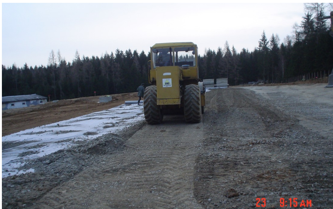
obr. č. 15 Podkladní vrstvy pod panely kompostovací plochy
