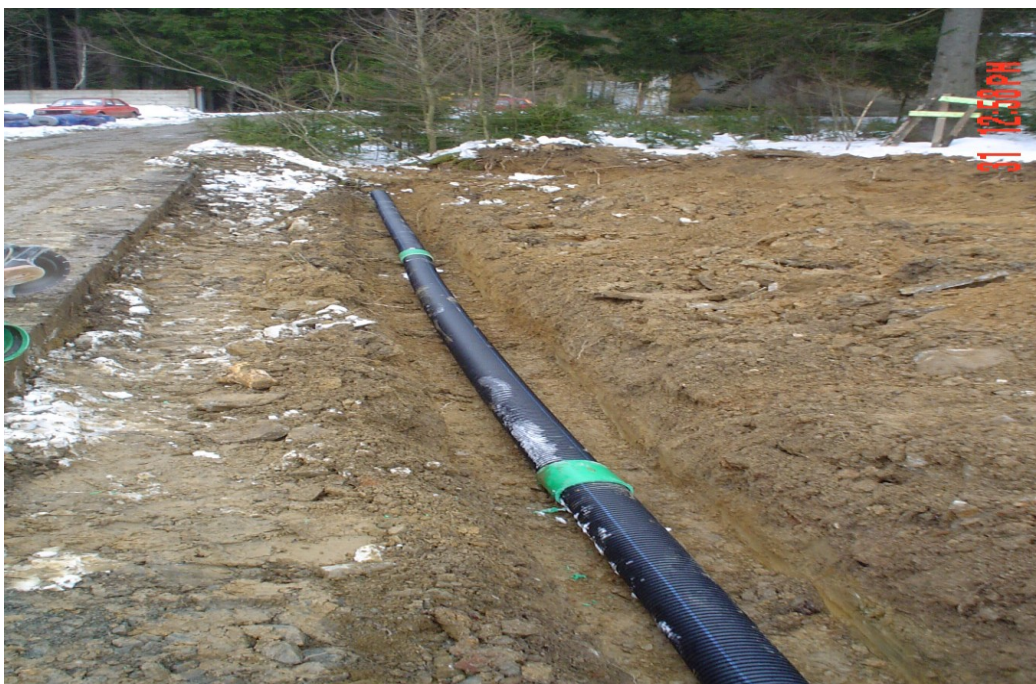
obr. č. 12 Pokládání vnitroareálového vodovodu
