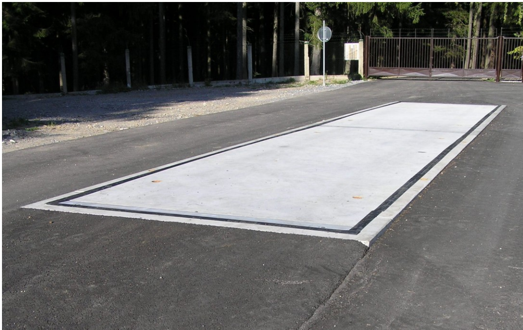
obr. č. 20 Dokončená mostní váha
