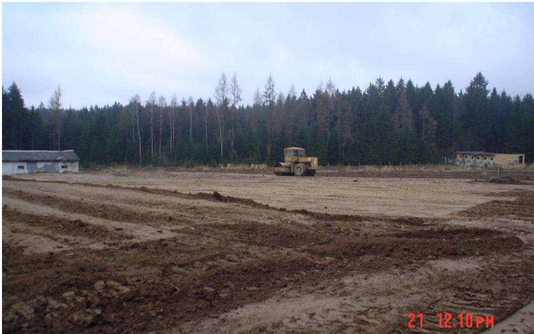
obr. č. 10 Úprava pláně pro kompostárnu
