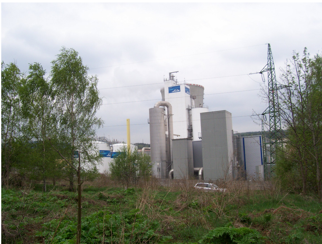
Obr. č. 14 Heracleum mantegazzianum v těsné blízkosti elektrárny (vlastní foto)
