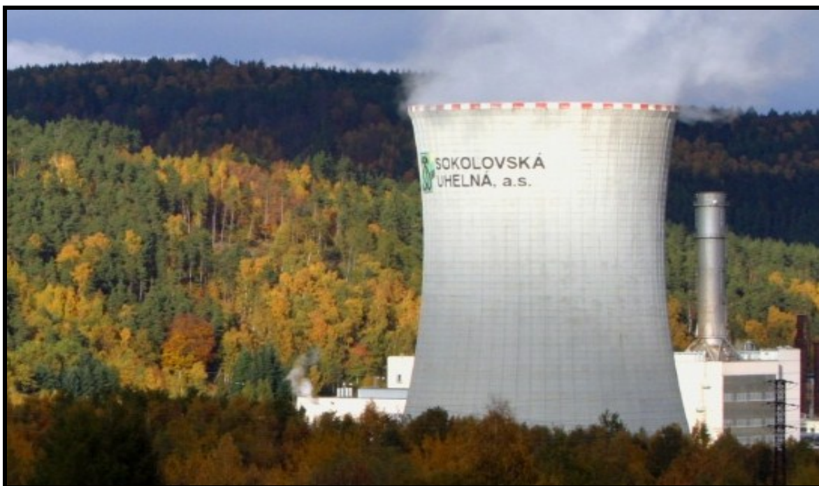
Obr. č. 2 – hlavní chladicí věž (foto: SU a.s.)
