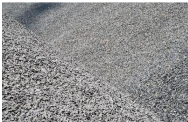
Obrázek č. 1.1.5-Drt', frakce 2-5, použití: podkladní vrstvy dlážděných komunikací
