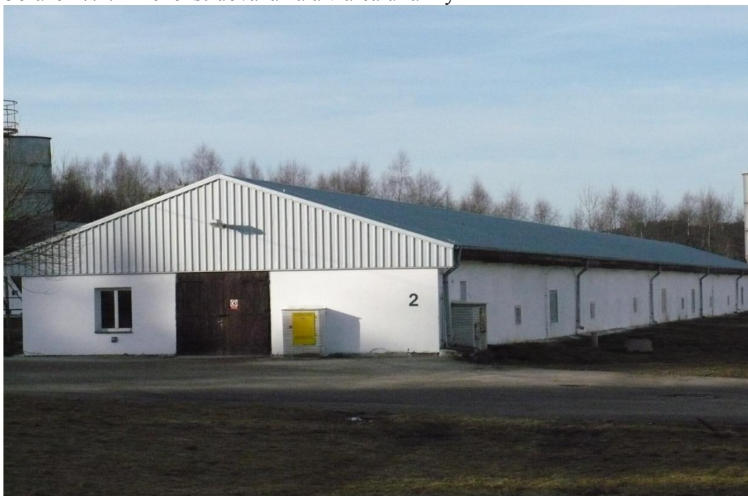
Obrázek 7.1.2 Zrekonstruovaná hala v areálu farmy
